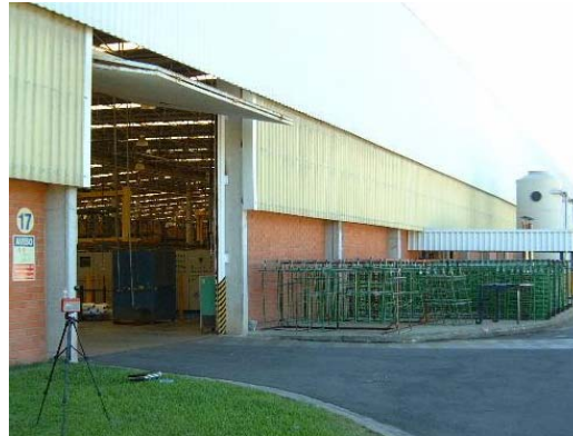
Figura 18- Vista parcial do Setor S10 – Área Externa
