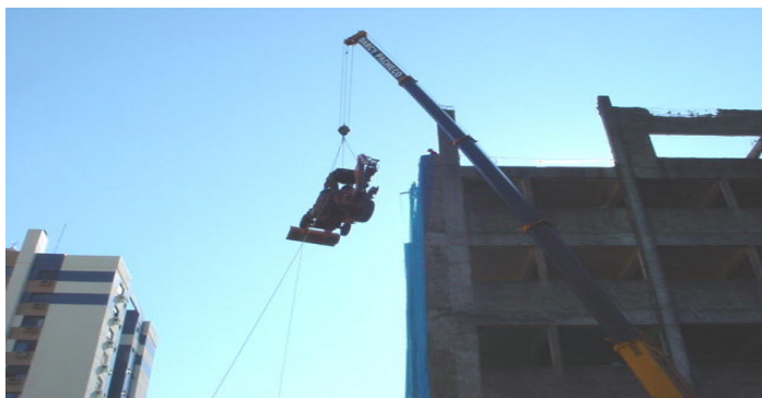
Figura 12: vista do içamento das retroescavadeiras
