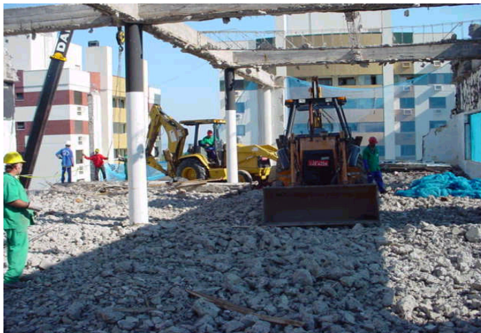
Figura 17: vista da distribuição das retroscavadeiras sobre a laje do 5º pavimento
