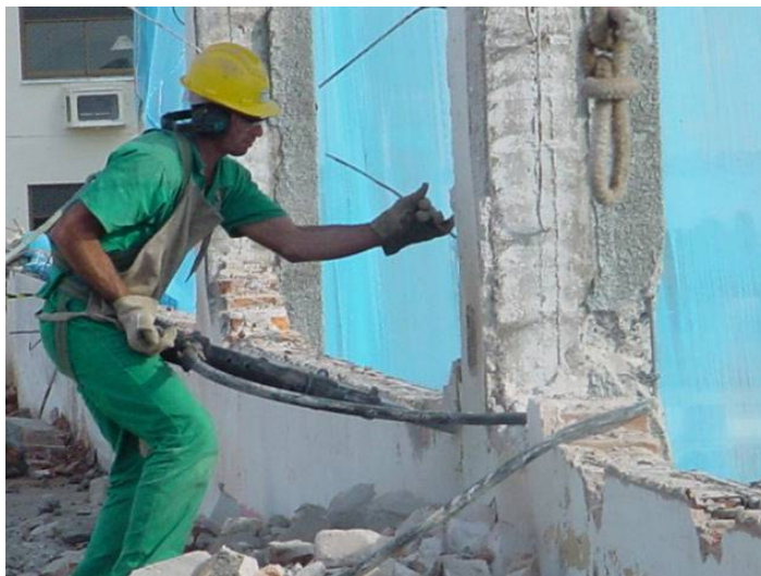
Figura 7: exemplo de utilização do Sistema Convencional com rompedor pneumático
