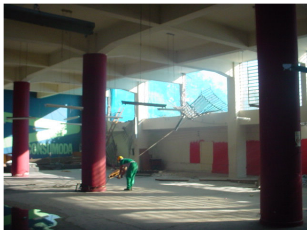
Figura 9: vista da retirada das esquadrias do pavimento térreo
