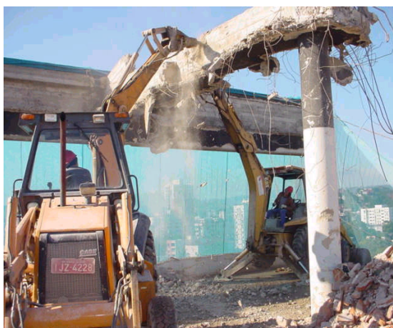
Figura 16: vista da demolição por colapso planejado de viga do 4º pavimento
