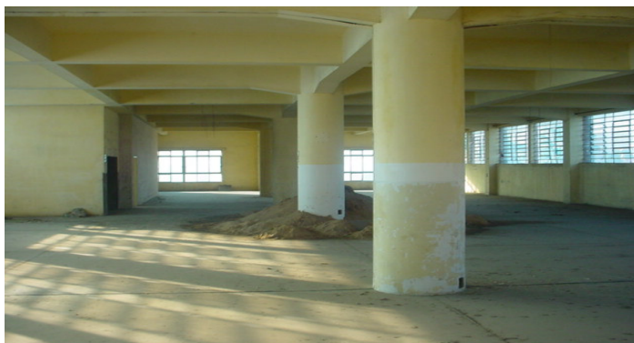
Figura 4: vista do pavimento tipo do prédio de concreto armado
