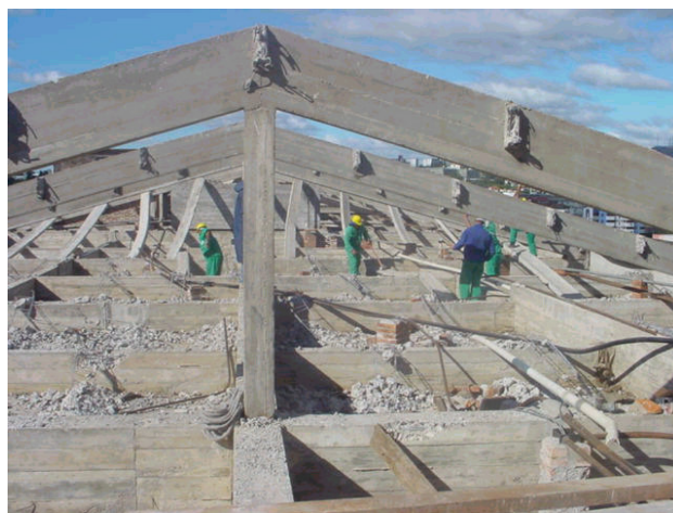
Figura 10: vista da demolição manual da cobertura em concreto
