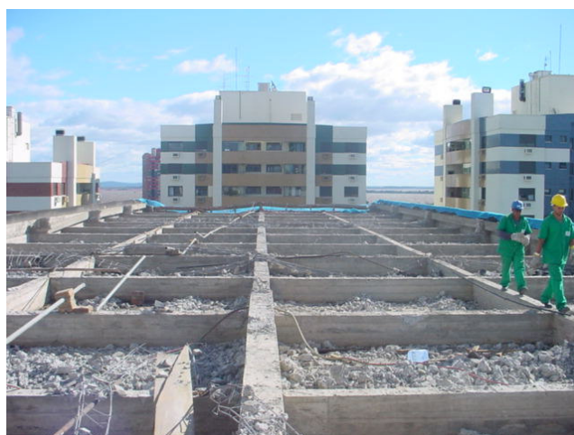
Figura 11: vista da demolição manual da cobertura em concreto armado
