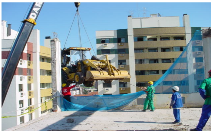
Figura 13: vista do posicionamento das retroescavadeiras no andar
