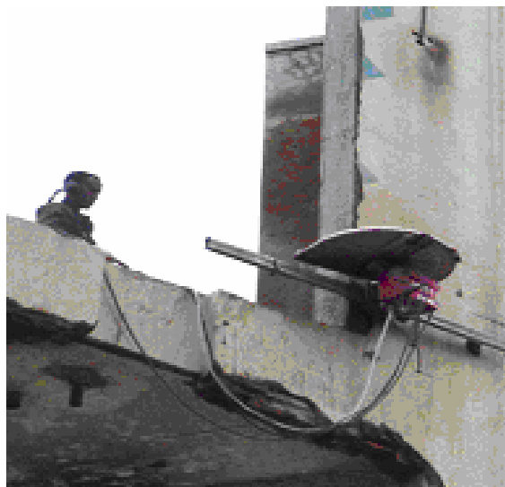
Figura 8: exemplo do corte com sistema diamantado de pilar de reservatório na cidade de Passo Fundo/RS
