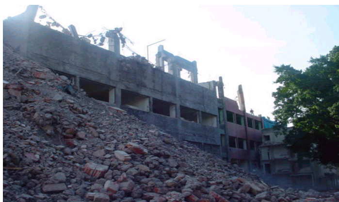
Figura 15: vista do colchão de entulhos formado na lateral do prédio demolido
