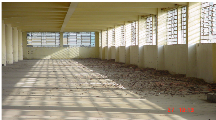
Figura 3: vista interna do pavimento tipo do prédio de concreto armado
