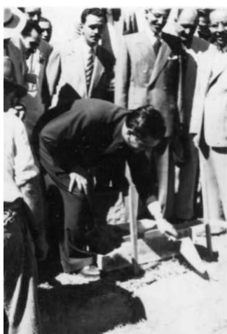
11b - Lançamento da Pedra Fundamental do conjunto habitacional, em 06 de abril de 1946. Na foto vemos o Prefeito de Porto Alegre, o Sr. Egídio Costa, deitar a 2ª colher de argamassa.
