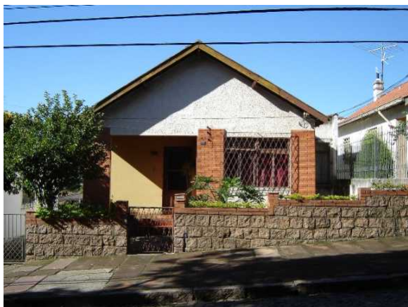
63 – Residência preservada, na rua João Moreira Alberto, próximo à escola Dom João Becker. Muitas das edificações ainda preservadas só se mantiveram assim devido à falta de recursos de seus moradores para executarem transformações maiores.
