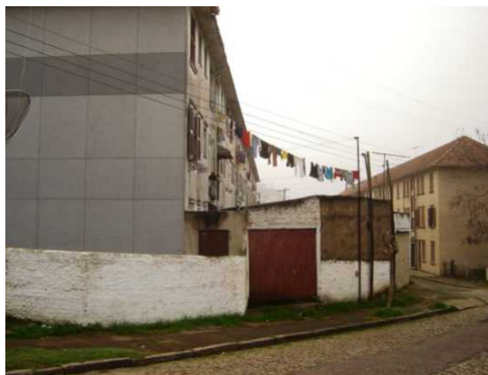
42 – Garagem construída irregularmente, na área de jardim, nos fundos de uma edificação multifamiliar na Vila do IAPI. A evolução tecnológica tornou fácil a aquisição de um automóvel, o que ocasionou a construção de dezenas de garagens irregulares, que não estavam previstas no projeto original, substituindo os canteiros para cultivo de hortaliças.
