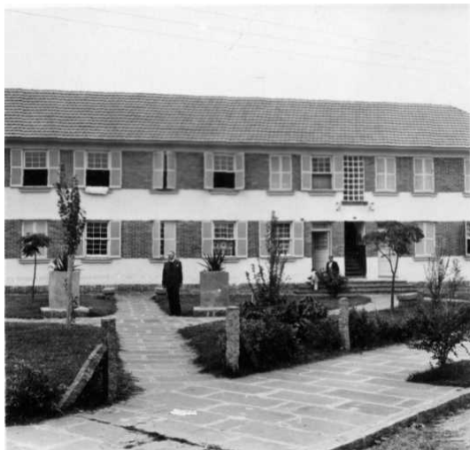
28 – Edificação multi-familiar de dois pavimentos, na Vila do IAPI, em 1954.
