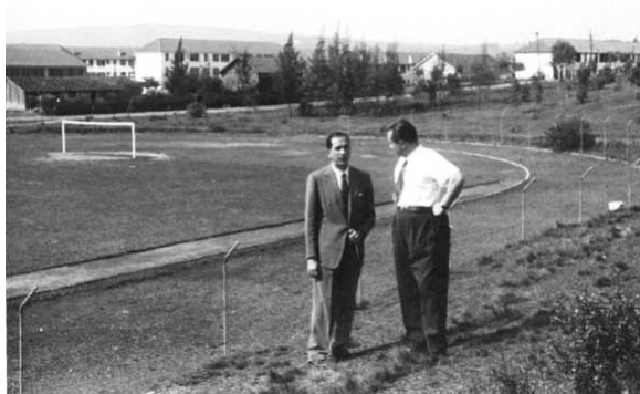
30 – Engenheiro Edmundo Gardolinski posa em frente ao Estádio Alim Pedro em 1954. O estádio fazia parte da estratégia do projeto de promover uma certa “autonomia cotidiana” para o conjunto habitacional através da instalação de vários equipamentos para a comunidade.
