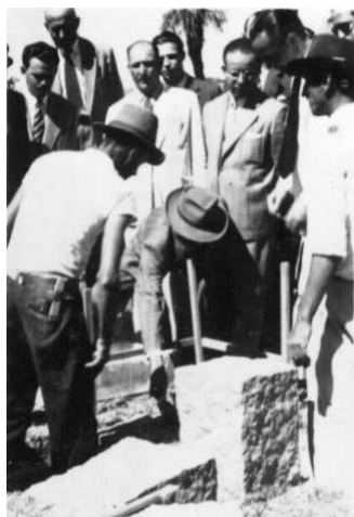
11a – Lançamento da Pedra Fundamental do conjunto habitacional, em 06 de abril de 1946. Na foto pode-se ver o Interventor Federal no Rio Grande do Sul na época, o Sr. Pompílio Cilon Fernandes Rosa, deitar a 1ª colher de argamassa.
