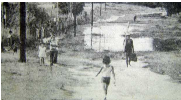
38 – Imagem de abandono pelo qual passava a Vila do IAPI em 1977 em reportagem do jornal Zero Hora. O mato e as poças d’água tomam conta dos jardins e áreas públicas, abandonadas pelo governo municipal.
