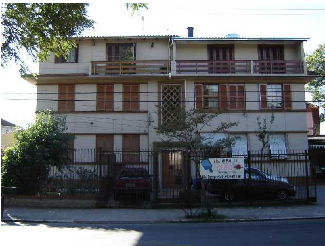
48 – As “transformações” na Vila do IAPI. Tipologia de dois pavimentos “ganha” um pavimento a mais, substituindo o tradicional telhado.
