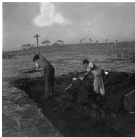
10 – Início dos trabalhos de terraplenagem na área do futuro conjunto habitacional do IAPI, no dia 22 de junho de 1945.
