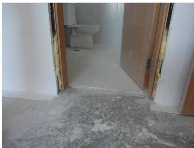
Figura 38 – Instalação do kit porta pronta antes da colocação da soleira
