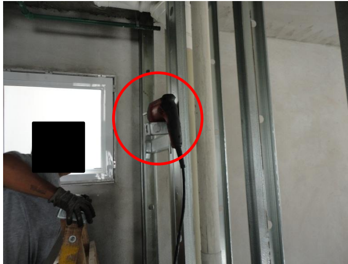
Figura 20 – Utilização de caixa elétrica para apoiar a furadeira
