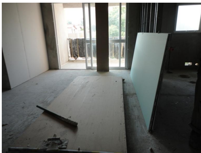
Figura 31 – Uso das placas como apoio para os materiais, ferramentas e equipamentos
