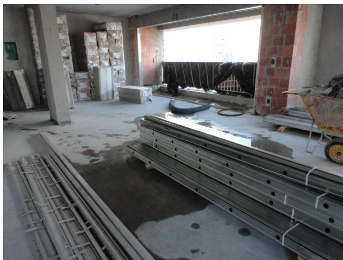
Figura 13 – Montagem das guias em apartamento não vedado, nem estanque e sendo utilizado como depósito de molduras
