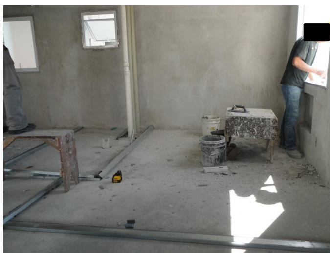
Figura 12 – Montagem das guias junto com arremates dos peitoris
