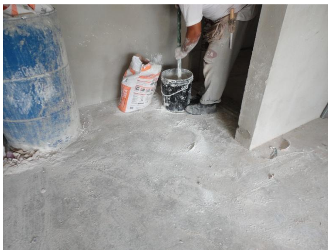
Figura 30 – Utilização de pedaço de tubulação para mistura de massa
