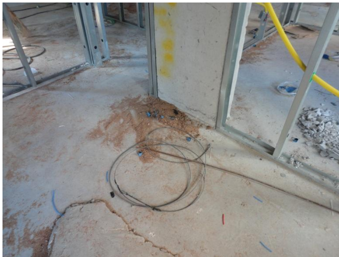
Figura 19 – Execução de instalações elétricas no dry wall em pavimento não limpo
