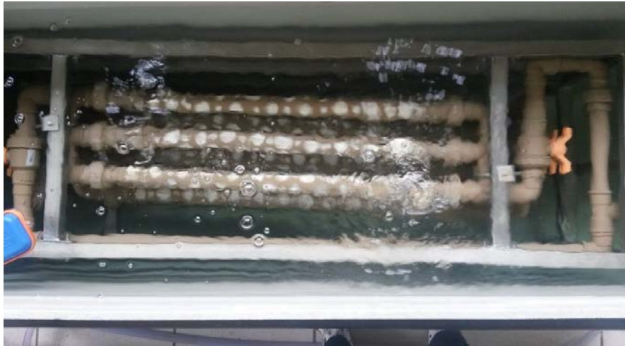
Figura 5.4: Fotografia das bolhas de ar devido a vazamentos nas membranas.
