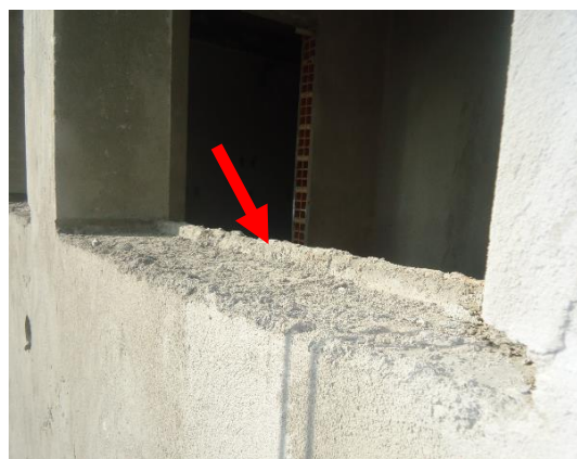
Figura 8 – Vista externa: detalhe do ressalto na contraverga
