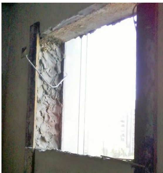
Figura 9 – Utilização de formas de madeira para requadro dos vãos
