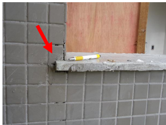
Figura 28 – Detalhe avanço lateral e ressalto do plano da fachada
