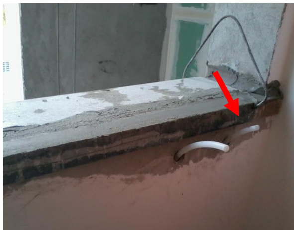
Figura 32 – Preenchimento do peitoril com argamassa
