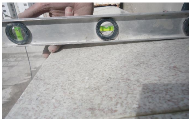
Figura 29 – Verificação do caimento dos peitoris
