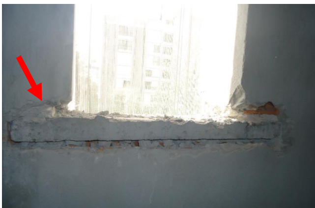
Figura 7 – Detalhe do avanço lateral da contraverga
