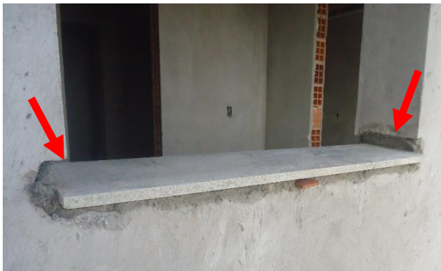
Figura 27 – Detalhe do encaixe para avanço lateral do peitoril
