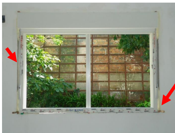
Figura 34 – Posicionamento da esquadria de PVC no vão
