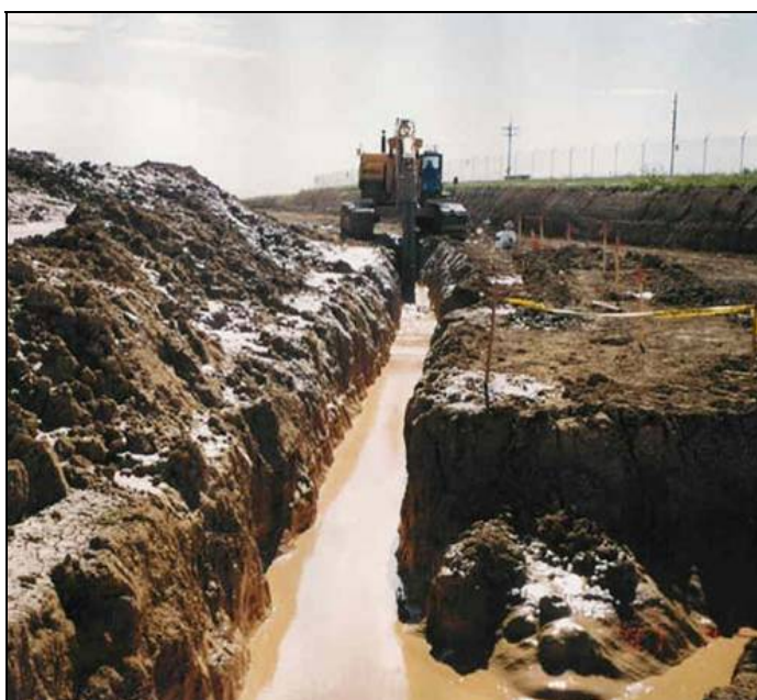
Figura 2.1: Escavação do trecho e lançamento da lama bentonítica (fonte: www.aestusinc.com ).
