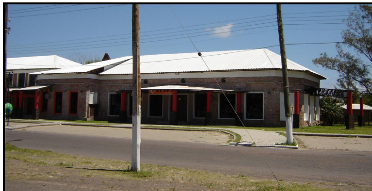
FOTOGRAFIA 7 – Prédio do antigo hotel Picoral em reforma
