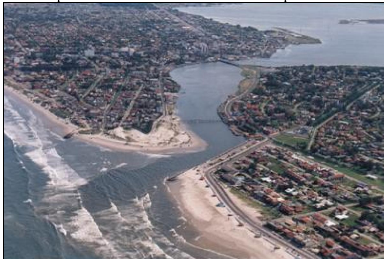
FOTOGRAFIA 9 - Retificação da desembocadura do Tramandaí, à esquerda o município de Tramandaí e a direita o município de Imbé na década de 1990.
