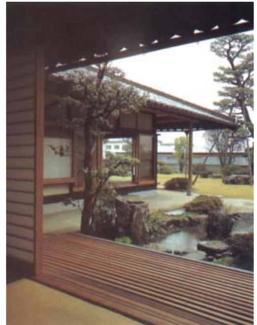
FIG.100- CASA DE MADEIRA – ESTRUTURA COLUNA E LINTEL.
