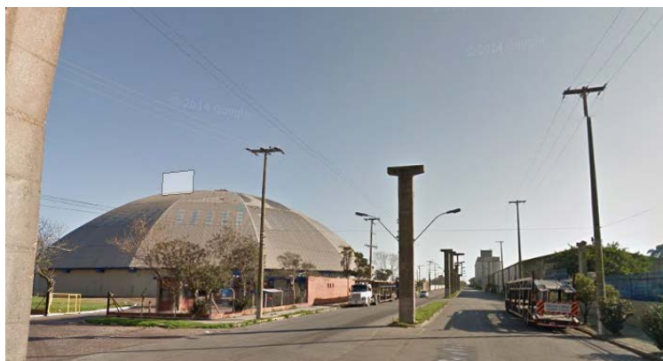
Figura 21 - Rua Honório Bicalho, pilares e armazéns abandonados. Fonte: GoogleStreetView.
