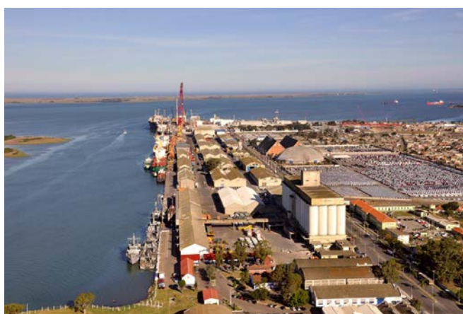
Figura 20 - Cais do Porto Novo atualmente. Fonte: SUPRG.
