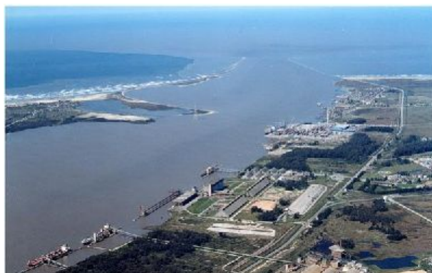
Imagem 3: Superporto, anterior às obras do dique seco e estaleiros, sentido Norte/Sul
