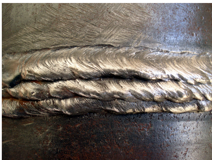
Acabamento da Junta J04
