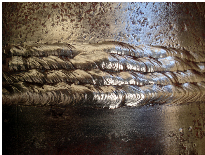
Acabamento da Junta J01 e J02
