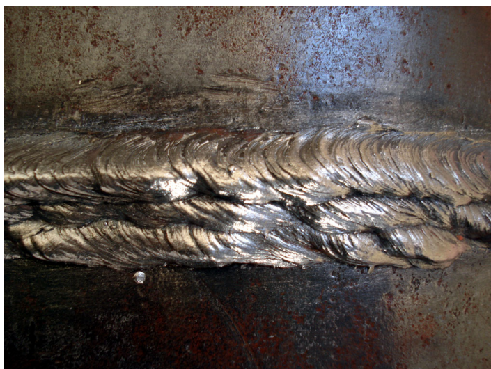
Acabamento da Junta J03
