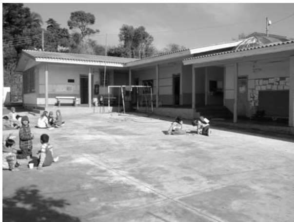
Fig. 12 - Espaço para recreio e estacionamento da EMEF Cônego Stanislau Olejnik
