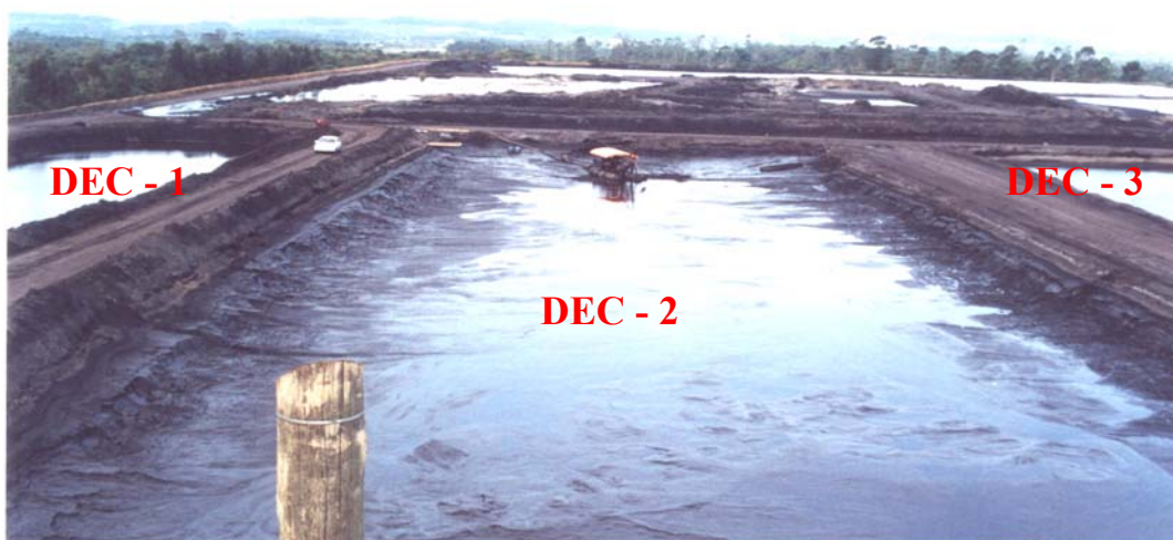
Figura 26. Aspecto da Remoção do Lodo do Decantador 2 – Módulo A (Fase sólida)
