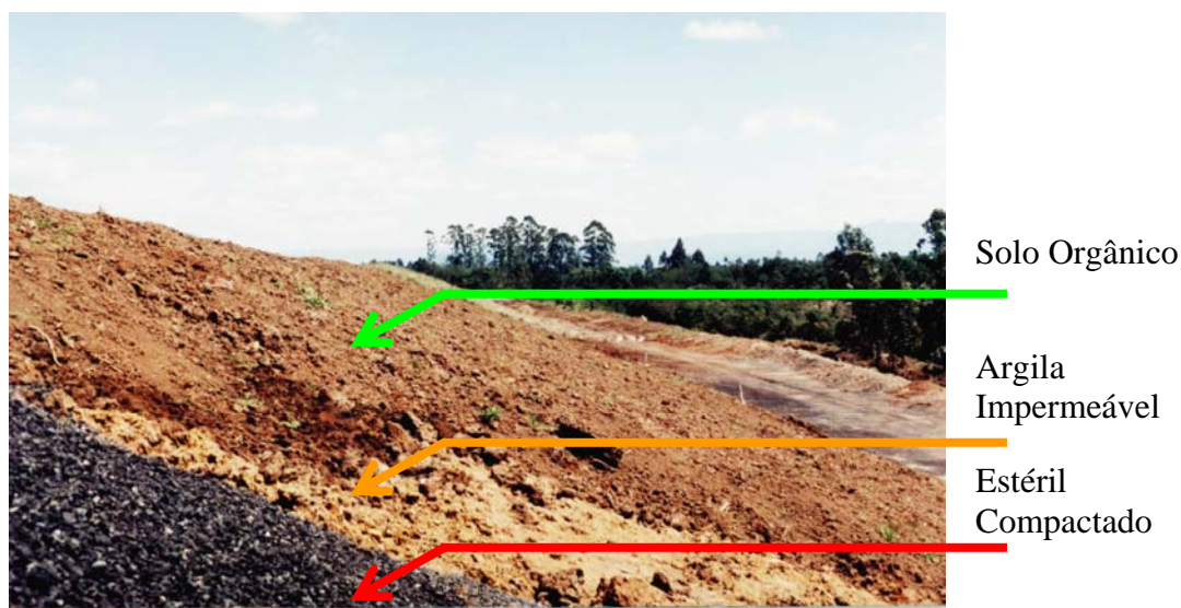
Figura 9. Perfil do Isolamento e Proteção de Taludes
