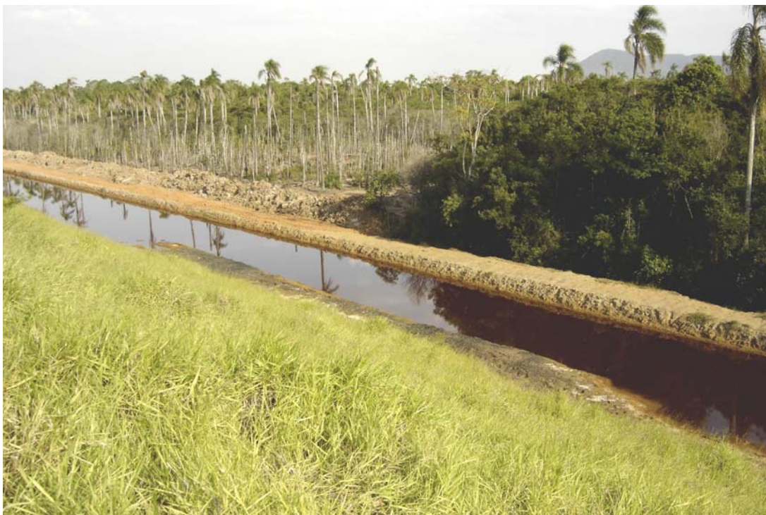
Figura 10. Flanco do Módulo B após Obras de Contenção (Janeiro/2000)
