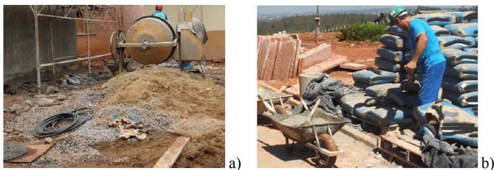
Figura 94: estoque de materiais (a) e dosagem de cimento com pá (b)
