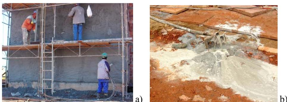
Figura 69: aplicação, sarrafeamento e desempenho (a) e desentupimento do mangote (b)
