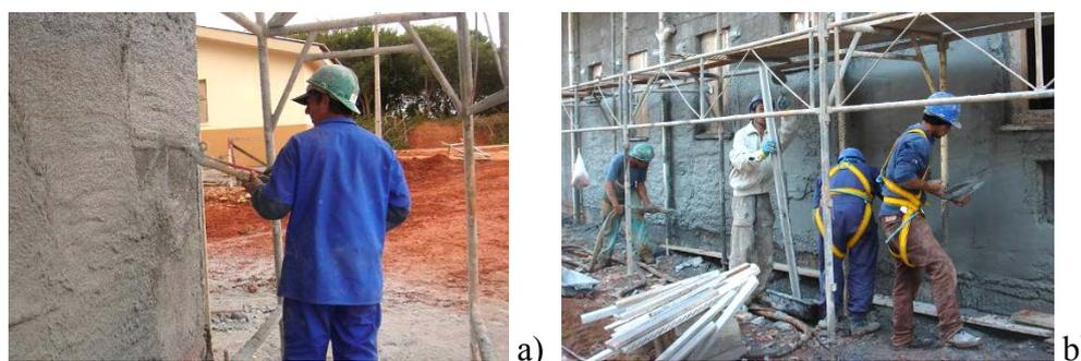
Figura 52: projeção de argamassa (a) e aplicação, sarrafeamento e desempenho (b)
