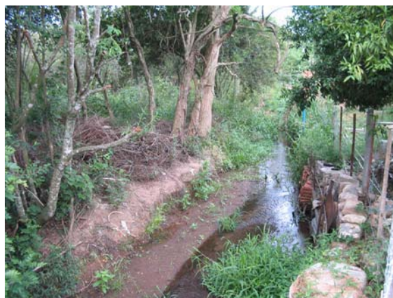
Figura 5 – Erosão e assoreamento no ponto de montante do arroio Capivara, Porto Alegre-RS, em janeiro de 2005.
