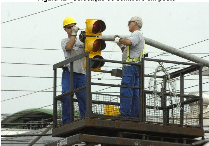
Figura 12 - Colocação de semáforo em poste
