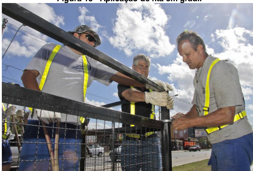
Figura 15 - Aplicação de fita em gradil
