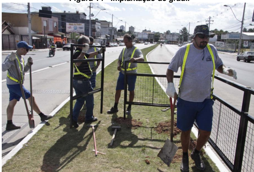
Figura 14 - Implantação de gradil
