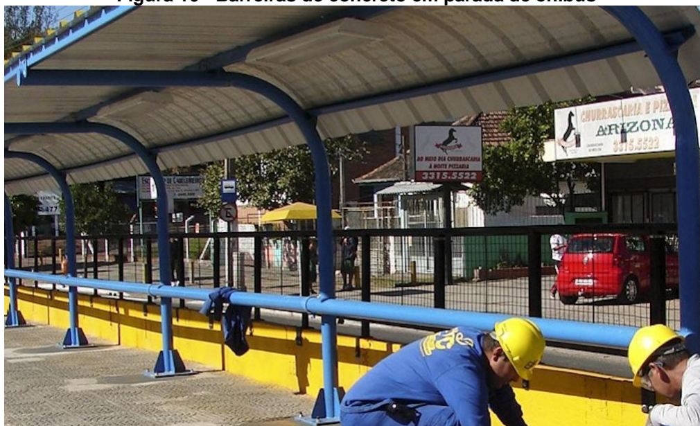
Figura 16 - Barreiras de concreto em parada de ônibus
