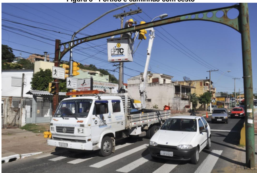
Figura 8 - Pórtico e caminhão com cesto
