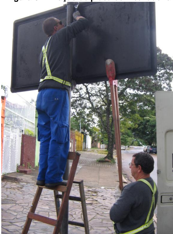
Figura 6 - Fixação de placa com cavadeira
