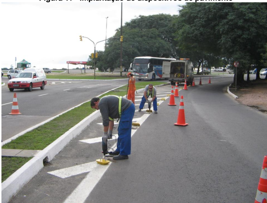
Figura 11 - Implantação de dispositivos de pavimento
