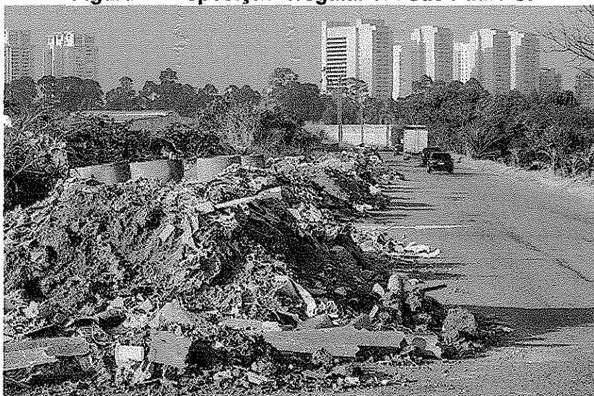
Figura 1 - Deposição irregular em São Paulo SP
