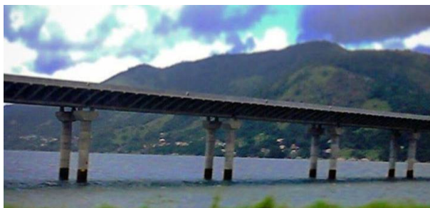
Colunas de ponte submetidas à interação fluido-estrutura (Ponte Anita Garibaldi, Laguna - Santa Catarina)
