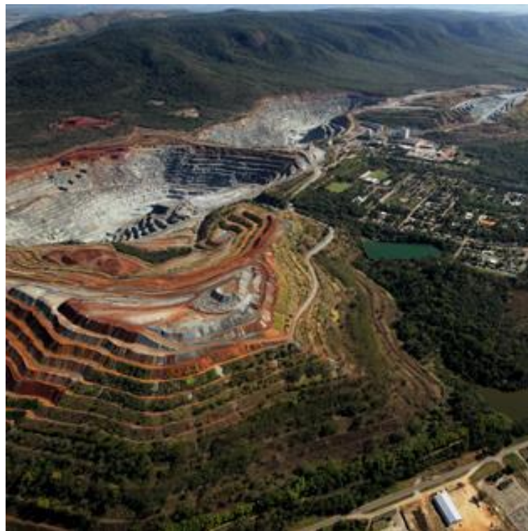
Figura 89: Pilha de estéril na etapa final de construção.
