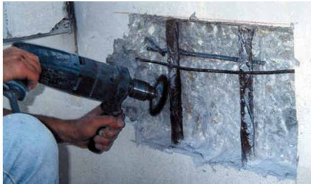
Figura 17 – Remoção de produtos da corrosão com lixadeira elétrica
