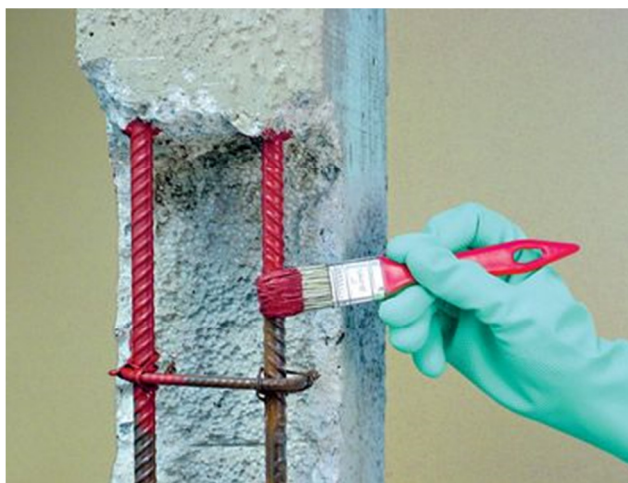
Figura 20 – Proteção da armadura com pintura
