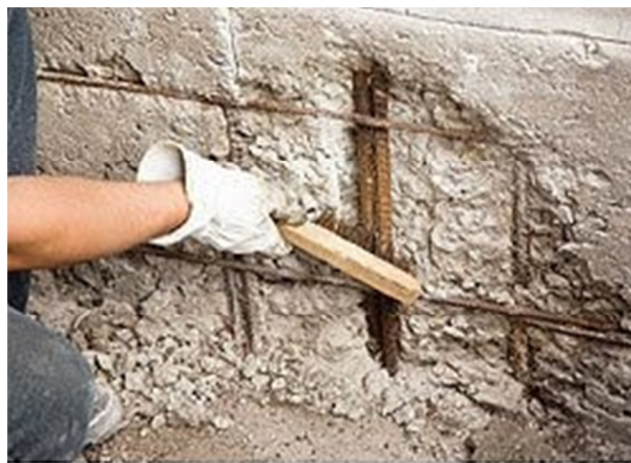
Figura 16 – Remoção de produtos da corrosão com escova com cerdas de aço
