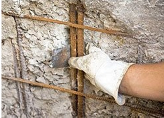
Figura 16 – Remoção de produtos da corrosão com lixa manual
