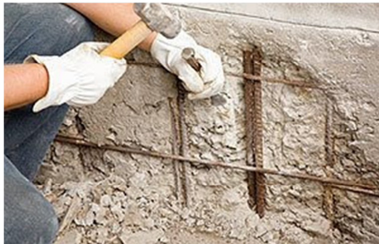
Figura 14 – Remoção do concreto com o uso de martelo e talhadeira
