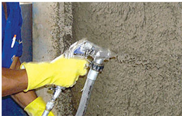
Figura 24 – Revestimento de argamassa projetável
