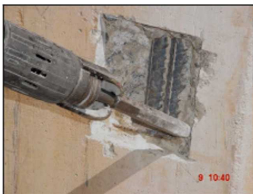
Figura 6 – Abertura de janela de inspeção
