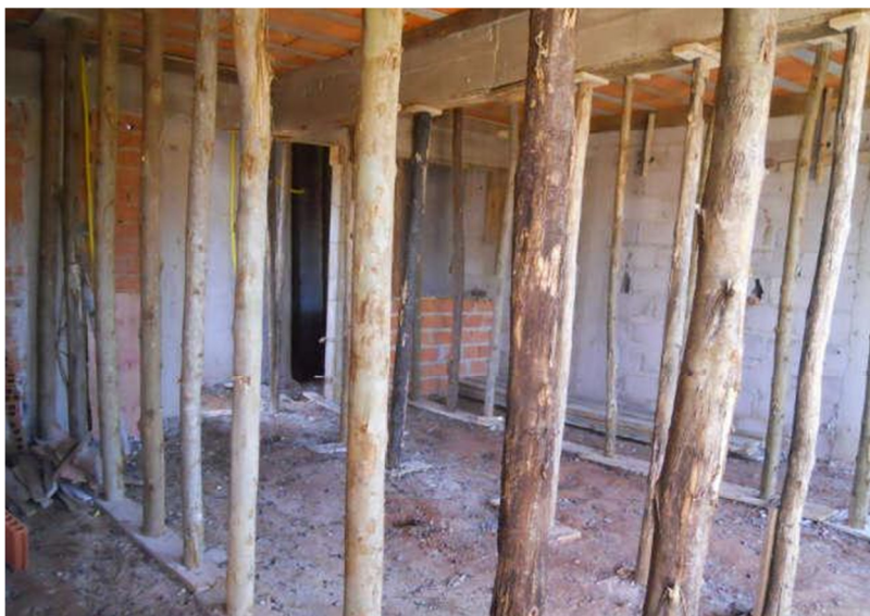
Figura 26 – Escoras de madeira
