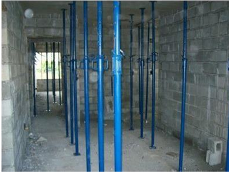
Figura 27 – Escoras metálicas
