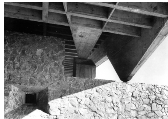
GARAGEM DE BARCOS DO SANTAPAU IATE CLUBE, 1961 VILANOVA ARTIGAS E CARLOS CASCALDI
