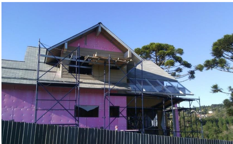
Figura 5 – Residência com cobertura de telha shingle
