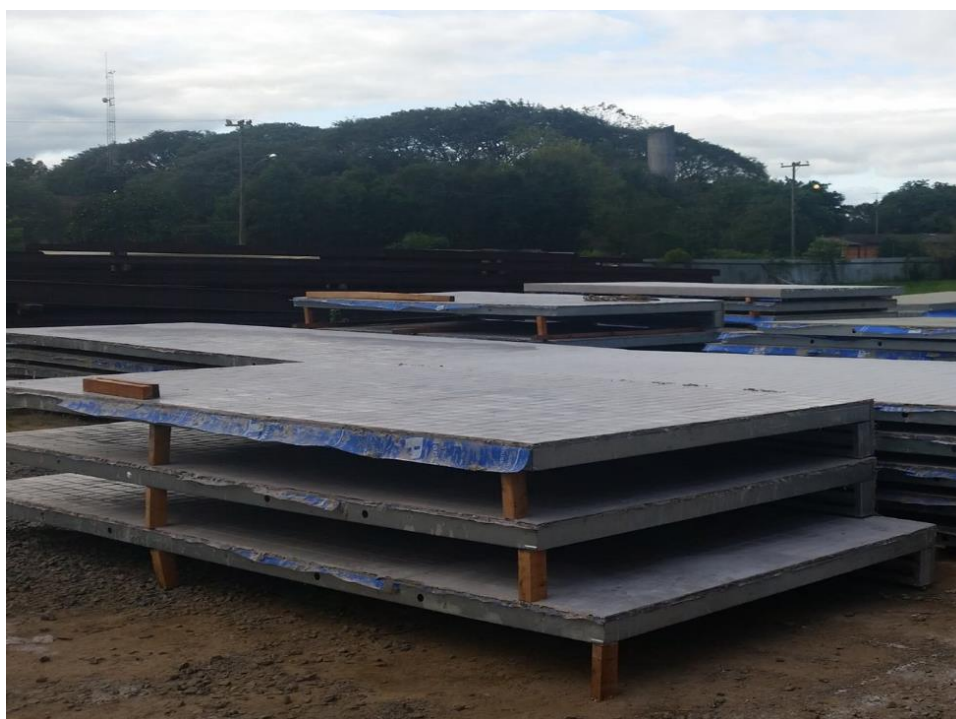
Figura 3 – Pré-montagem de painéis LSF
