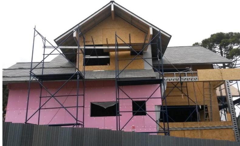
Figura 28 – Aplicação das chapas OSB e XPS
