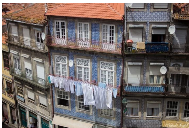
Figura 10 – fachadas azulejadas na cidade do Porto, Portugal
