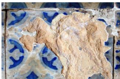
Figura 26 - desagregação do biscoito, possivelmente provocada por cristalização de sais solúveis
