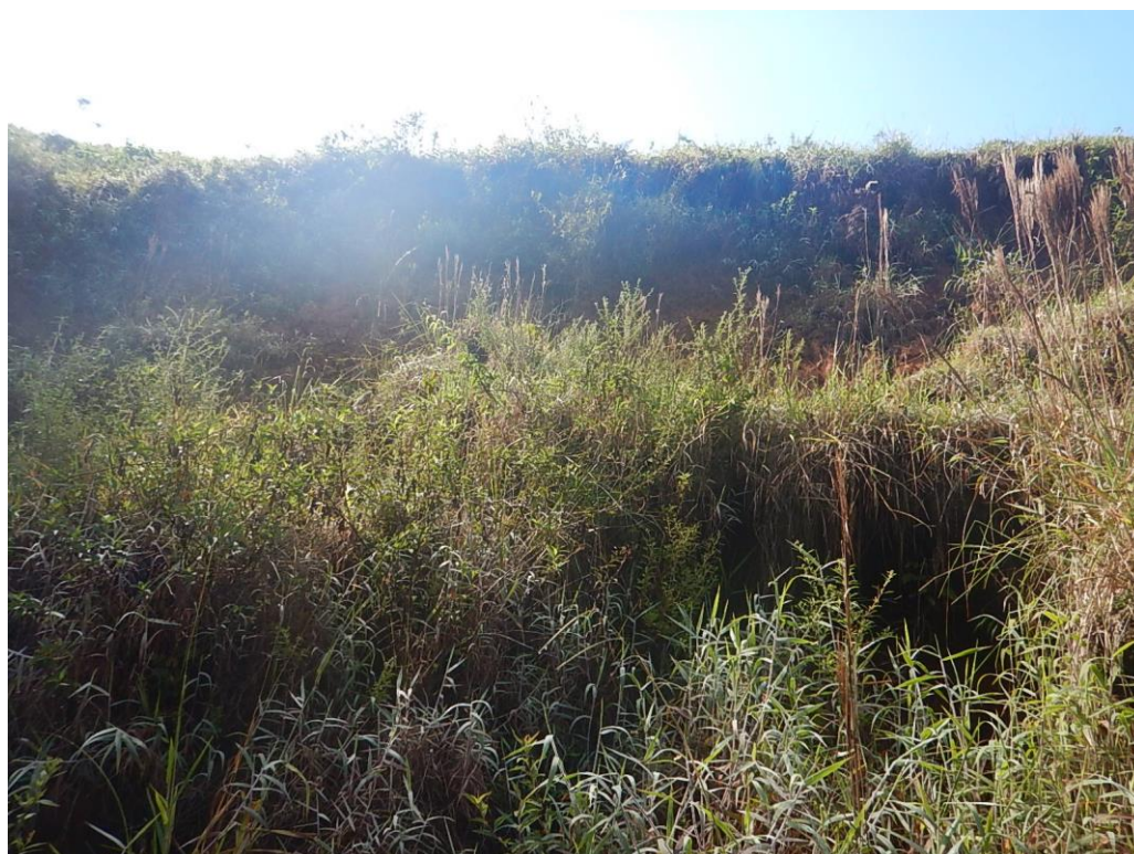
Figura 20 – Visão geral da ruptura do ponto 02
