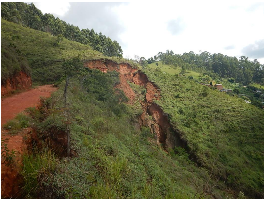
Figura 25 – Visão geral da ruptura do ponto 05
