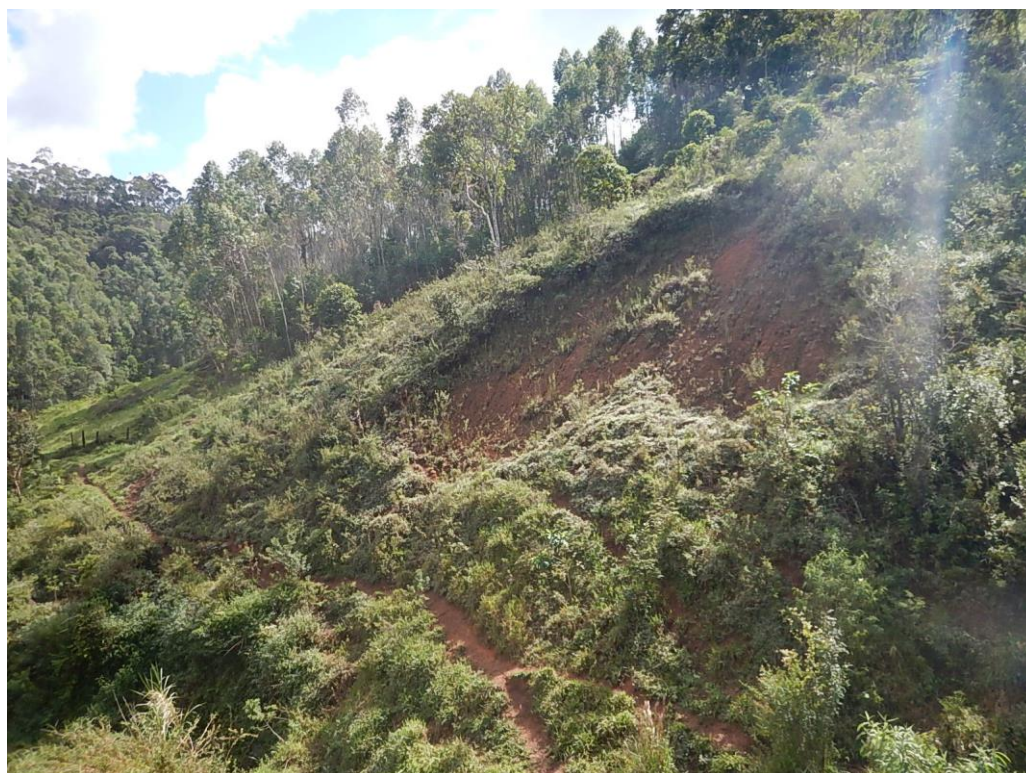
Figura 22 – Visão geral da ruptura do ponto 03
