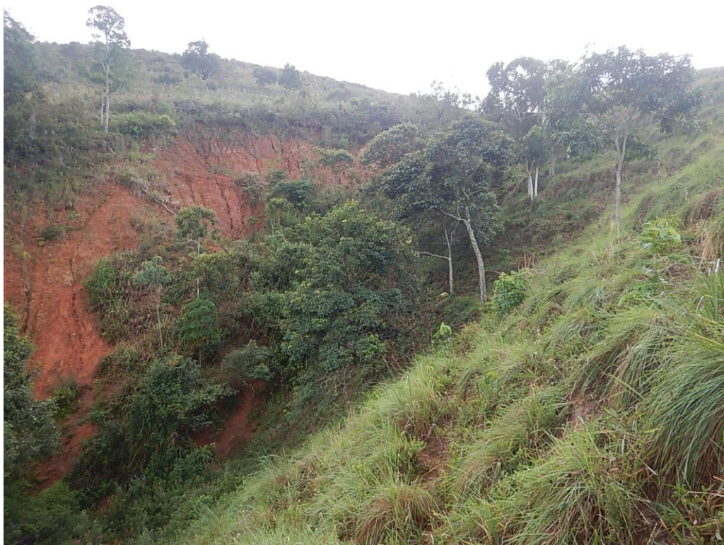
Figura 18 – Visão geral da ruptura do ponto 01
