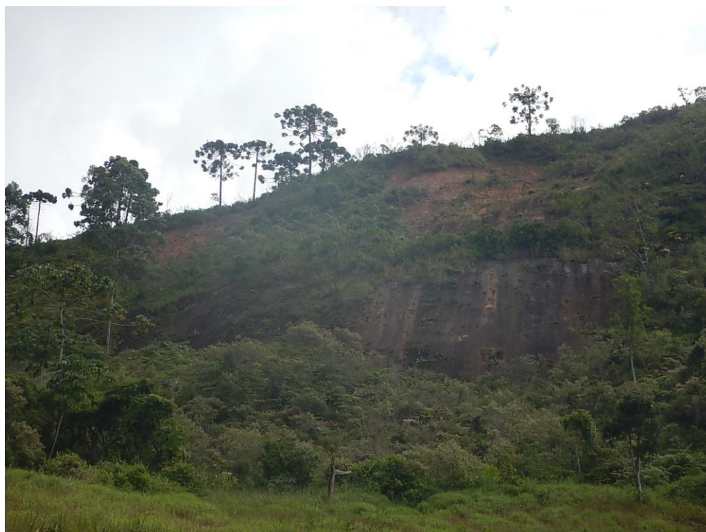
Figura 24 – Visão geral da ruptura do ponto 04
