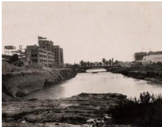
Figura 20. Arroio Dilúvio durante as obras de canalização. Ao fundo, a ponte da Avenida João Pessoa e à esquerda o Palácio da Polícia. (PMPA, 2008)
