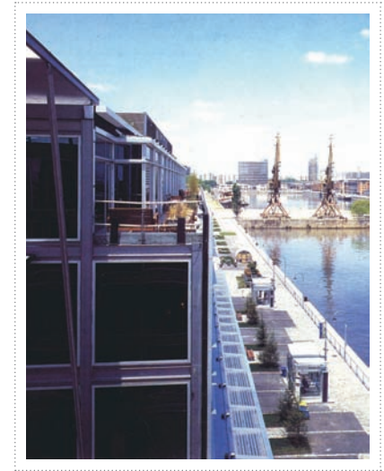
Figura 166. Fachada lateral entre as edificações e terraço de cobertura.
