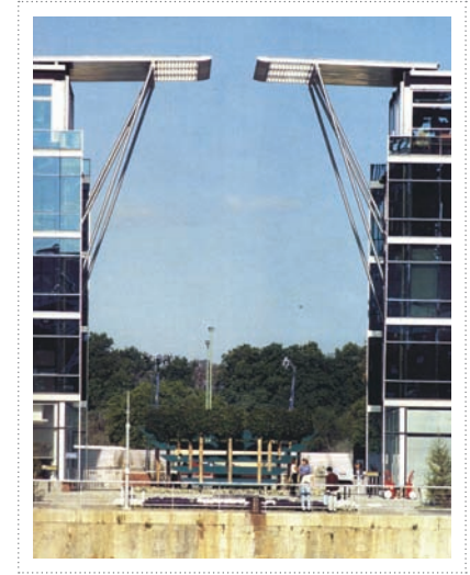
Figura 167. Vazio entre as edificações.
