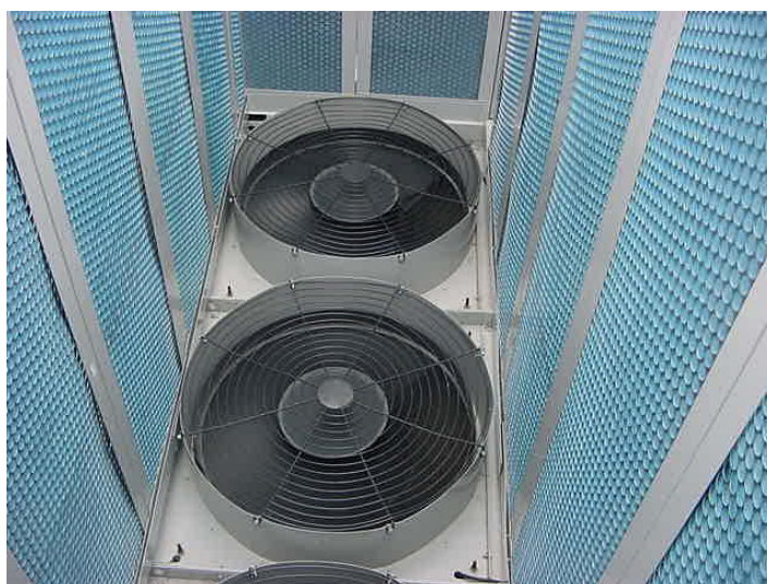
Figura 8.7 – Dutos retangulares na descarga dos ventiladores
