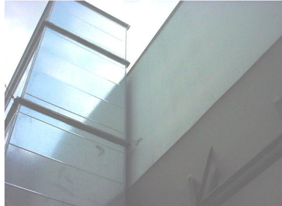
Figuras 4.1 e 4.2 – Túnel para tratamento acústico que resultou na quebra de vários compressores.
