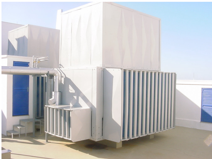
Figura 9.2 – Grande quantidade de células de atenuação necessárias para uma atenuação efetiva
