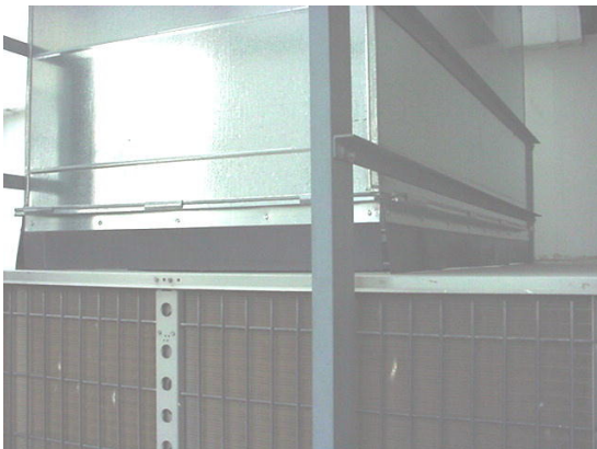
Figuras 4.1 e 4.2 – Túnel para tratamento acústico que resultou na quebra de vários compressores.
