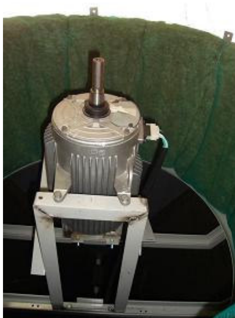
Figura 9.6 – Suporte com 500 mm de altura apoiado na estrutura original
