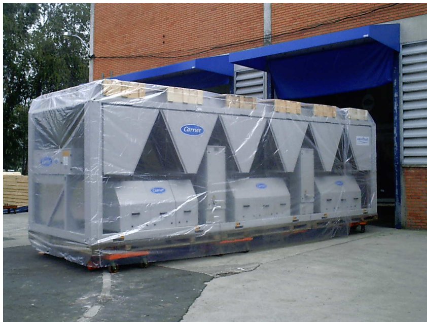
Figura 9.4 – Nova plataforma de chillers que utiliza condensadores em estrutura modular
