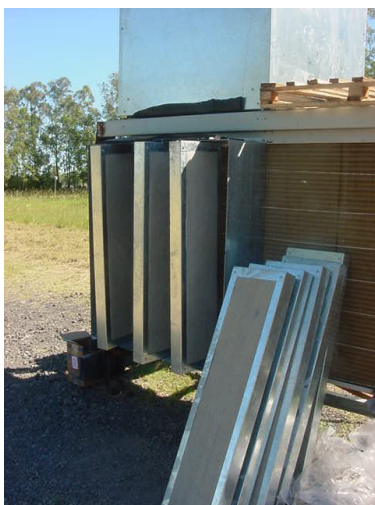
Figura 8.2 – Instalação de 3 células de atenuação equidistantes
