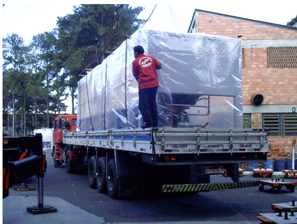
Figura 2.3 - Chiller com capacidade de 358 TR.
