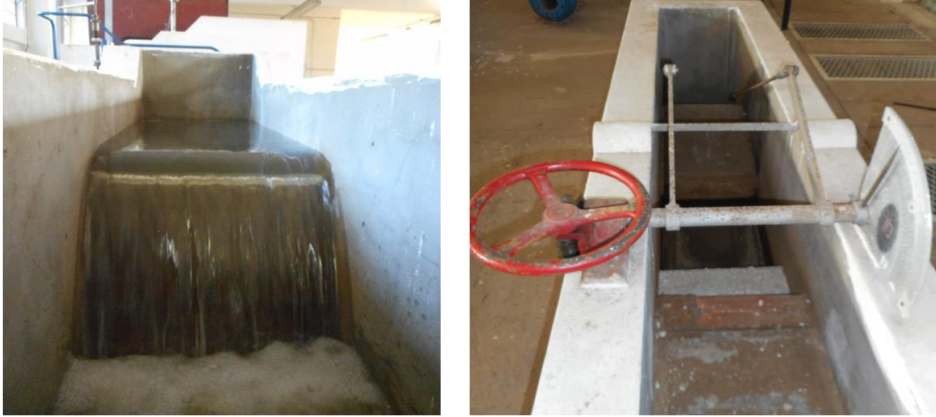
Fig. 12: Vertedor à esquerda e comporta de jusante à direita.
