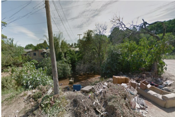
Fig. 9: Arroio Salso na altura da Estrada Costa Gama, nº 5000, localmente conhecido como “Vila Cocô”. imagem captada a partir do aplicativo Google Maps . Em 20/04/2014
