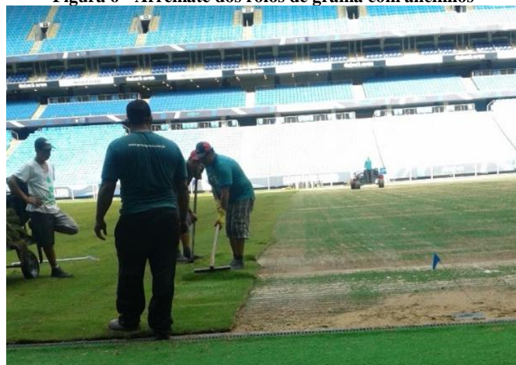
Figura 6 - Arremate dos rolos de grama com ancinhos
