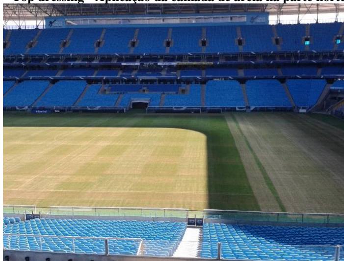
Figura 11 – Top dressing - Aplicação da camada de areia na parte norte do estádio
