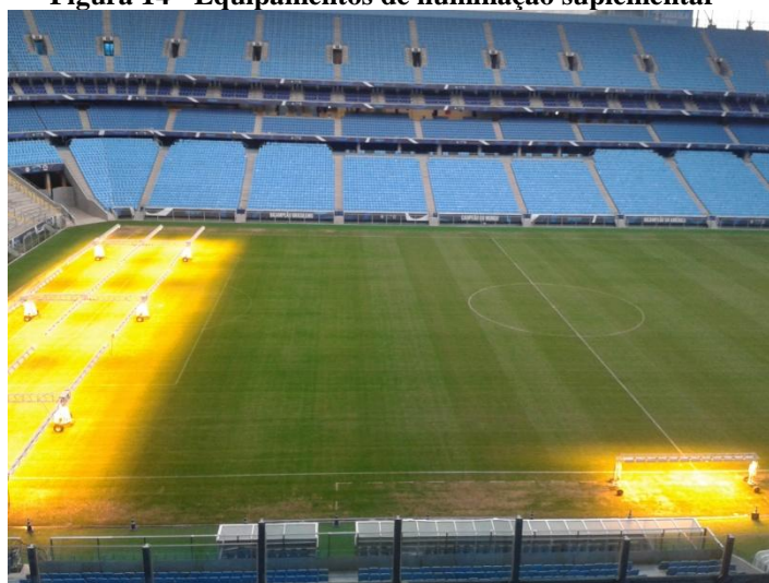
Figura 14 - Equipamentos de iluminação suplementar
