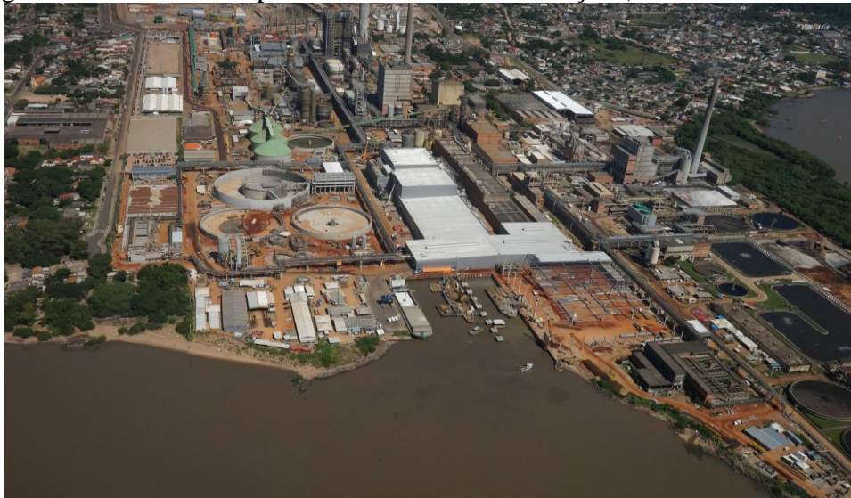
Figura 1. Vista aérea da planta industrial em construção (CMPC – Guaíba/RS).
