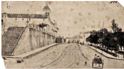
Figura 17 - Santa Casa à esquerda e Praça Dom Feliciano à direita (início séc. XX)
