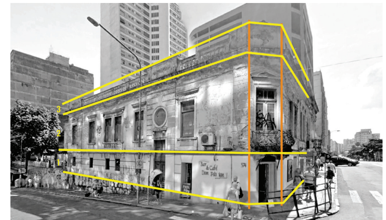
Figura 50 - Composição tripartida verticalmente, por inserção de cimalkhas que marcam os pavimentos e a platibanda.
