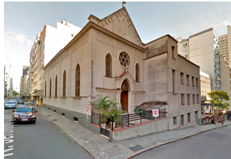
Figura 5 - Casa de Apoio - capela (arquivo pessoal)
