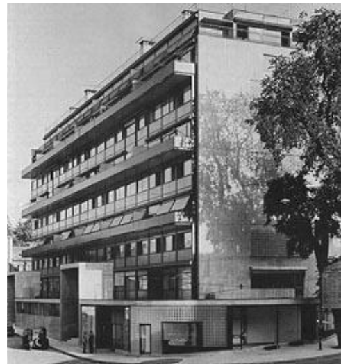
FIGURA 4 | Edificio Clarté, Ginebra. En este edificio la losa a medios pisos se extendía más allá de la línea de la fachada de vidrio. Fuente: Boesiger Zurich (1984).
