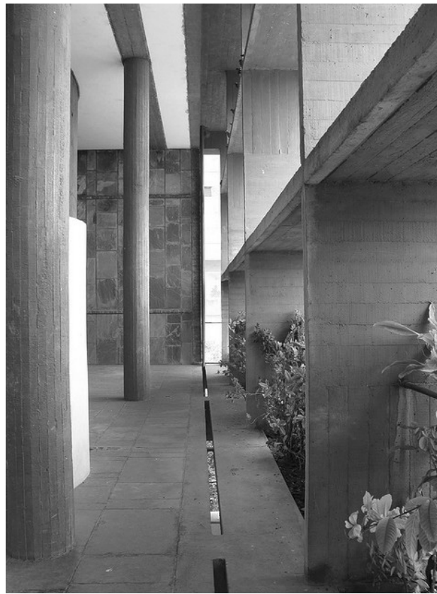
FIGURA 13 | La Asociación de Hilanderos de Ahmedabad. Brise-soleil de la fachada este, como elemento compositivo (que soporta los elementos vegetales) visiblemente separado de la fachada. Fuente: acervo de los autores.
