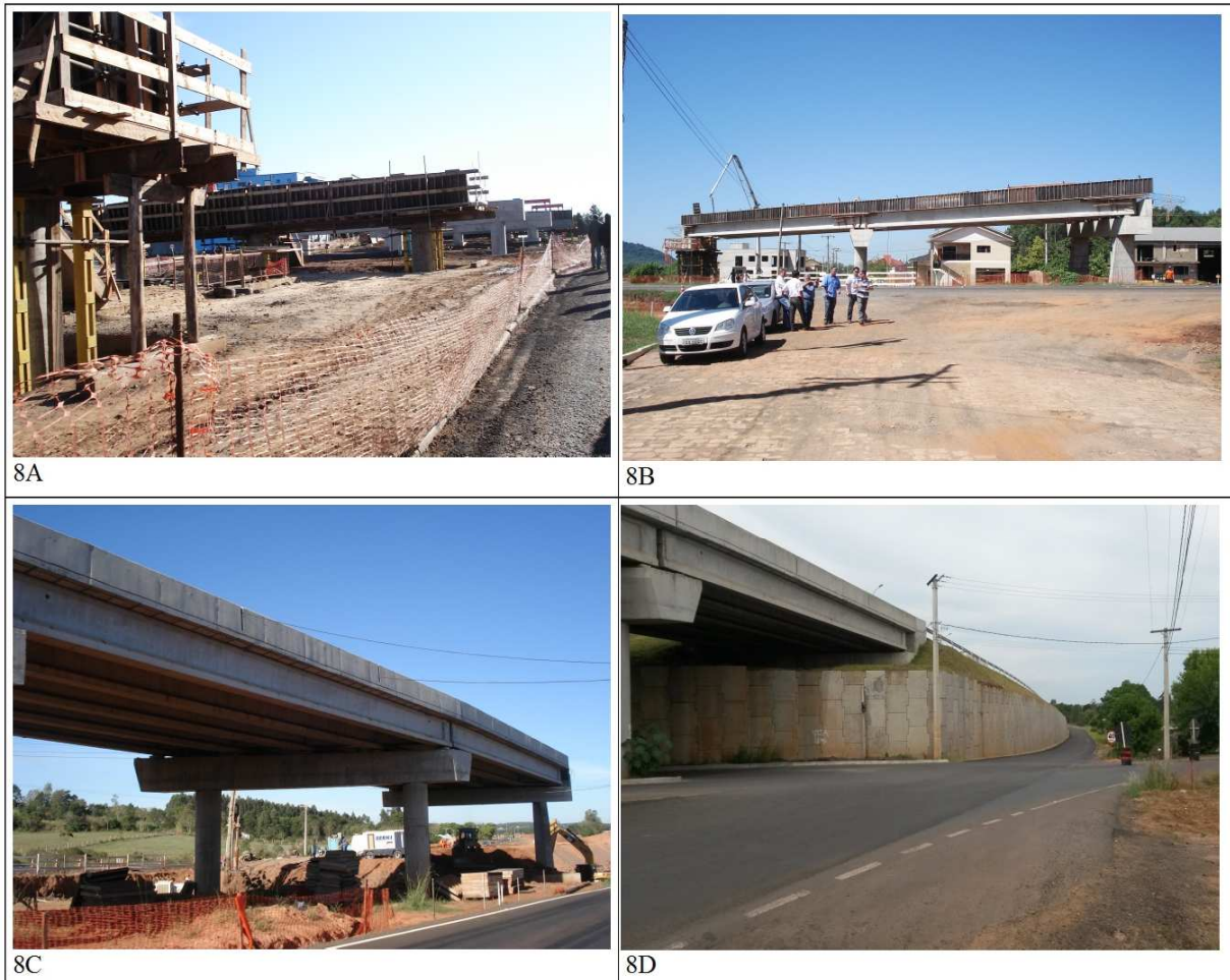
Figura 8 – Aspectos do viaduto construído em Tabaí, BR 386/RS.
