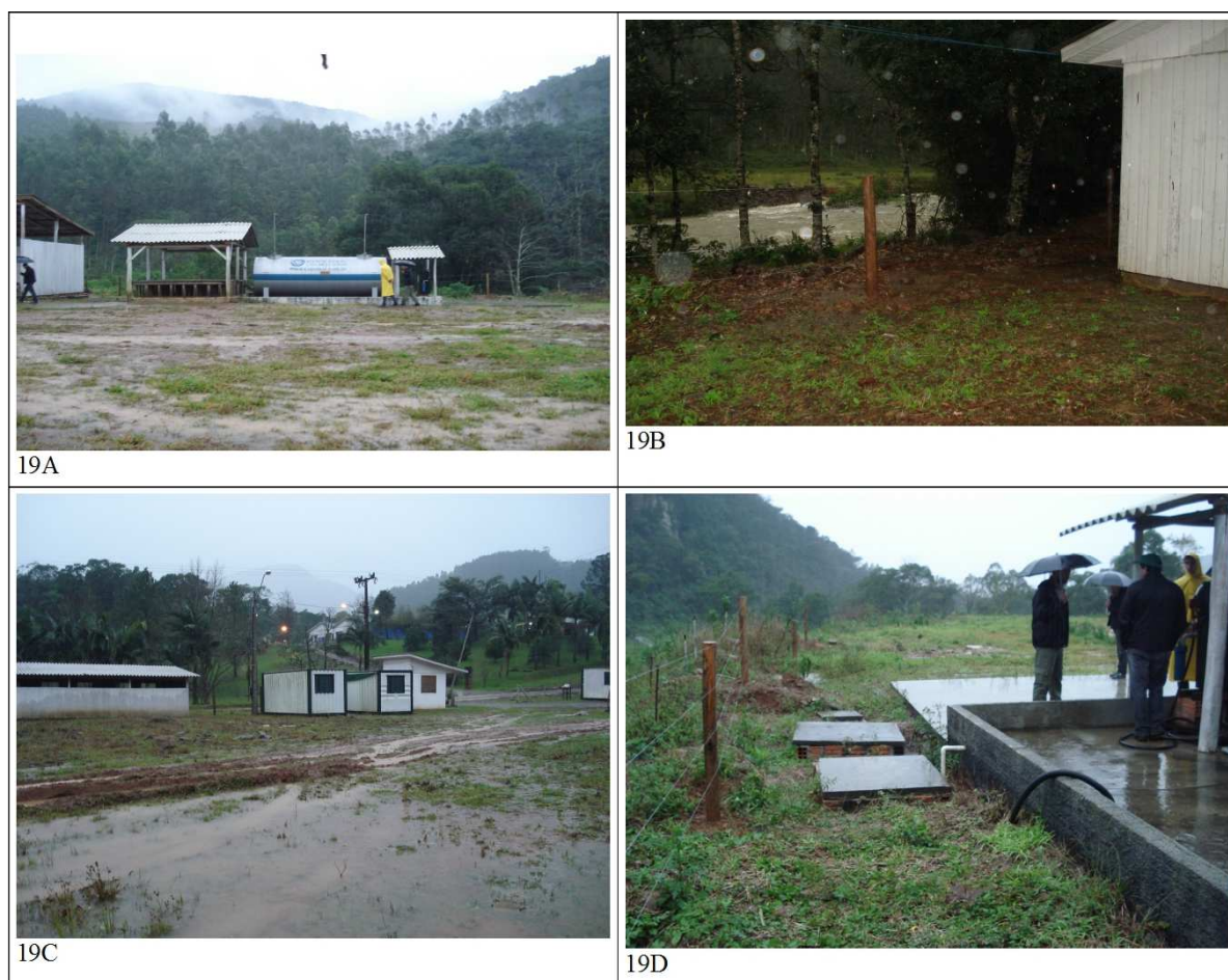
Figura 19 – Aspectos do Canteiro de Obras do Lote 2, BR 285 RS/SC.
