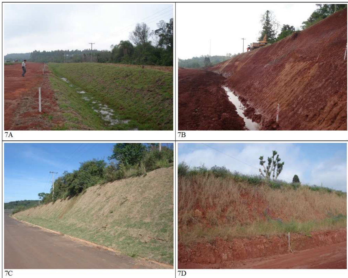
7A) Taludes de aterro enleivados (2011); 7B) Talude de corte (2011); 7C) Talude de corte com enleivamento (2013); 7D) Talude de corte com hidrossemeadura (2011).
