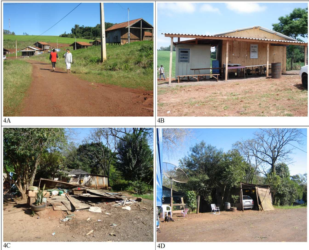
4A) Residências da aldeia Kaingang de Estrela; 4B) Escola da aldeia Kaingang de Estrela; 4C) Ocupações de baixa renda na faixa de domínio; 4D) Ocupações de baixa renda na faixa de domínio.
