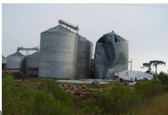
Figura 2.10 – Fotos de acidentes de silo causados por vento.
