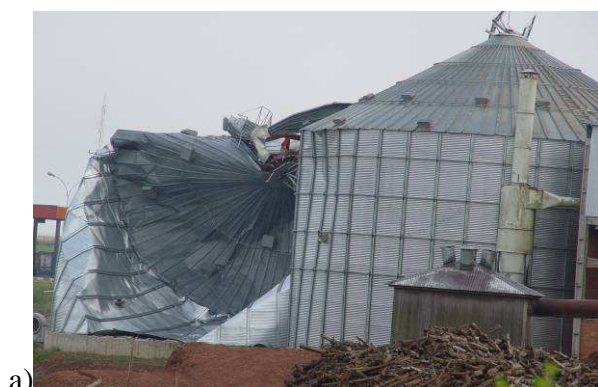
Figura 2.10 – Fotos de acidentes de silo causados por vento.
