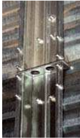
Figura 4.2 – Foto de montante com a alma contendo um enrijecedor intermediário.
