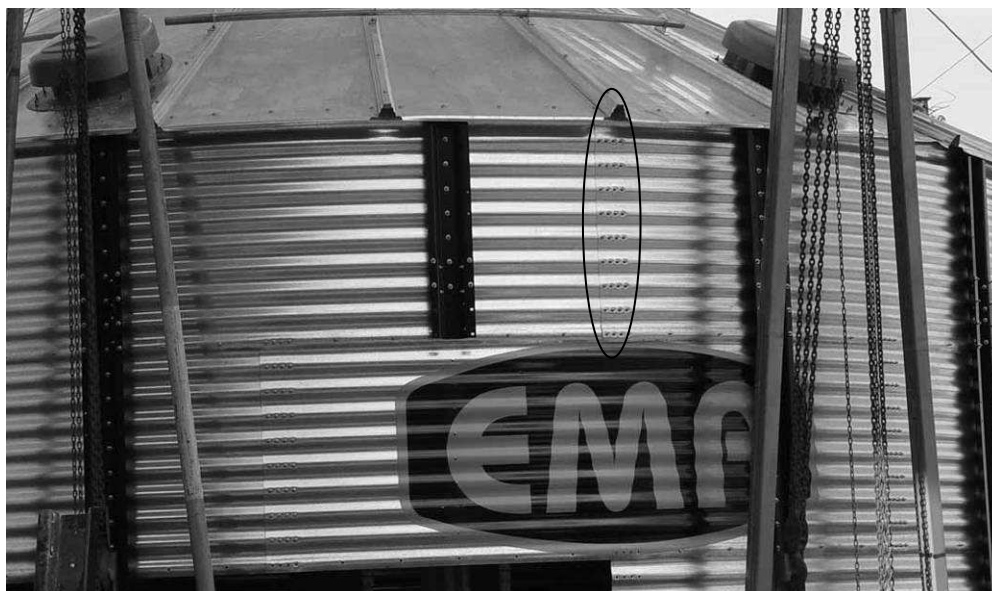
Figura 7.1 – Detalhe das ligações parafusadas.
