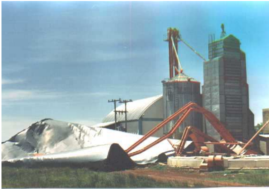
Figura 2.4 – Foto de acidente de silo durante montagem e detalhe de chumbador adequado.
