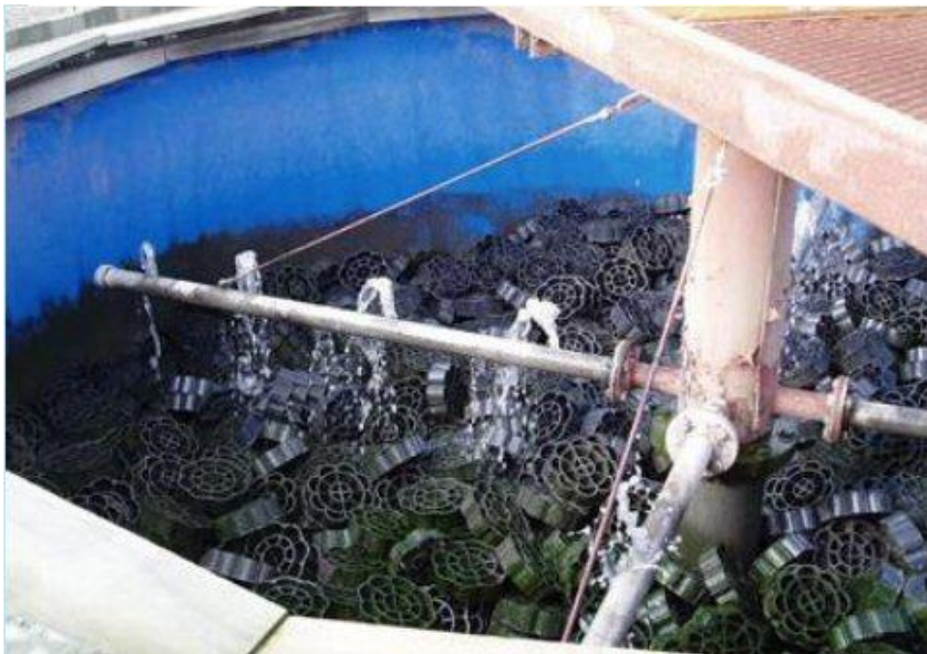
Figura 4 – Reator Biológico com anéis plásticos randômicos
