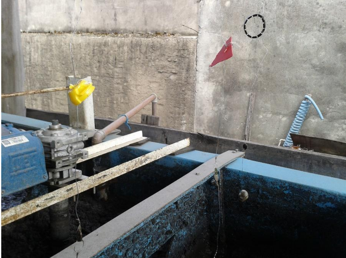
Figura 10 – Colocação das amostras nas câmaras de esgoto
