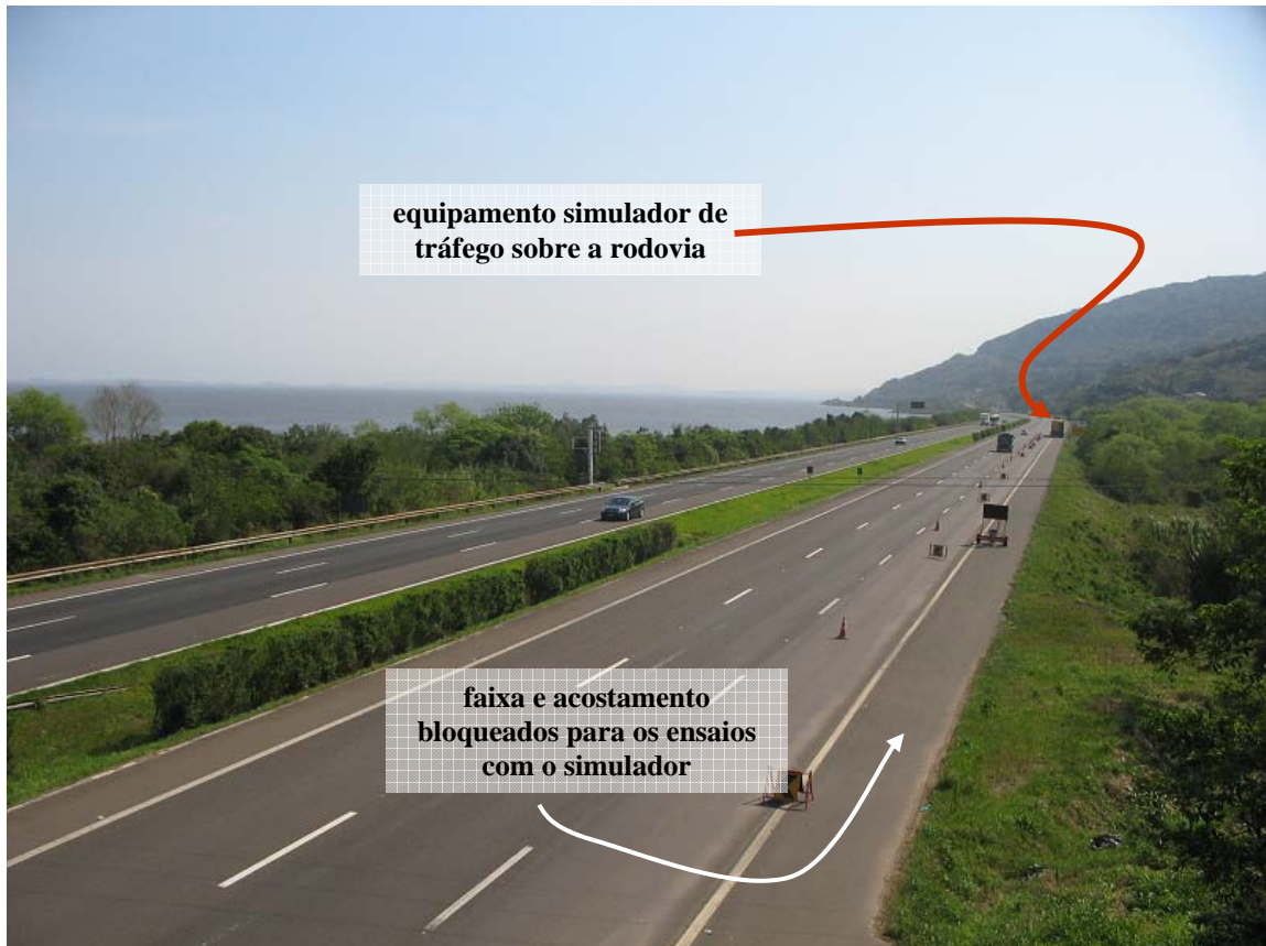
Figura 16: Vista do km 5 da rodovia BR-290/RS, local do ensaio com o simulador de tráfego.
