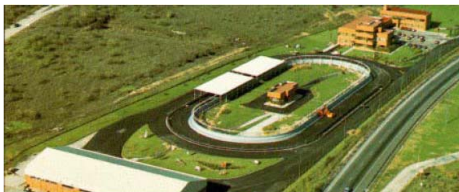
Figura 6: Área de testes de pavimentos do CEDEX (TRB, 2006, apud Rohde, 2007).
