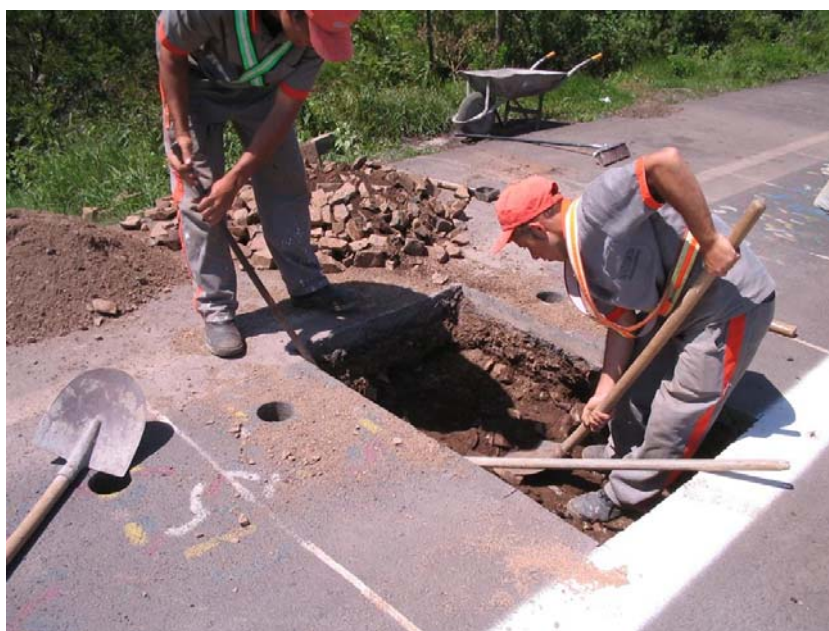
Figura 49: Poços de inspeção abertos nos locais dos ensaios acelerados.
