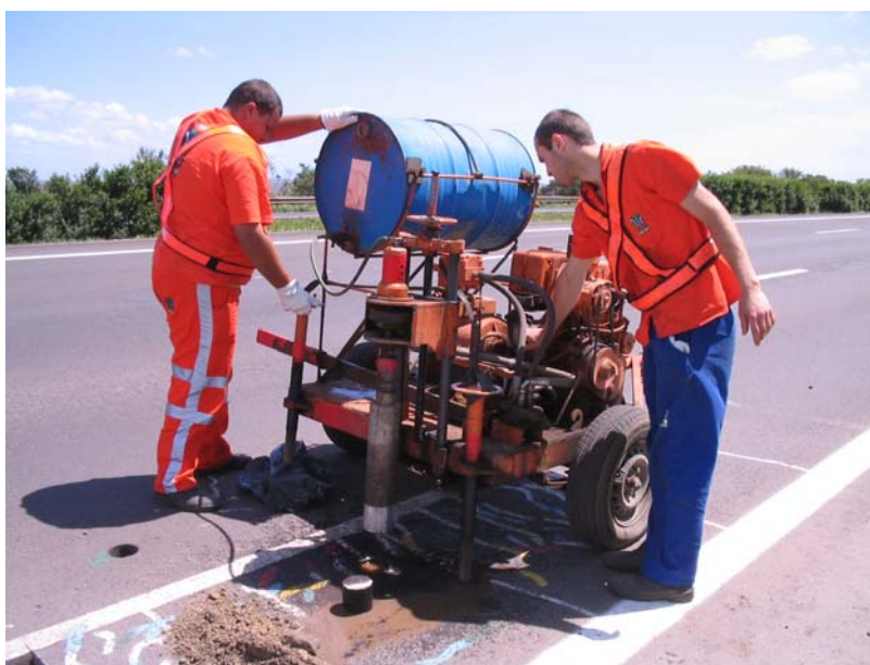
Figura 46: Extração de corpos-de-prova no trecho ensaiado pelo simulador de tráfego na rodovia BR-290/RS.
