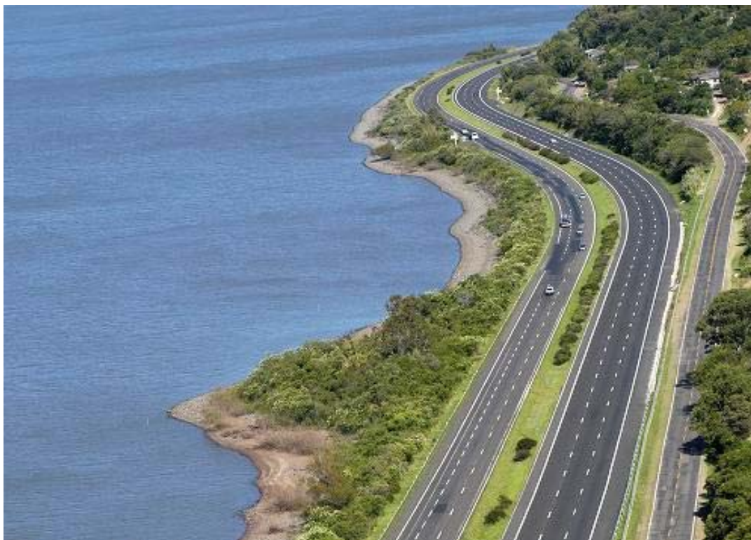
Figura 12: Vista geral atual da Rodovia BR-290/RS (Concepa, 2007).
