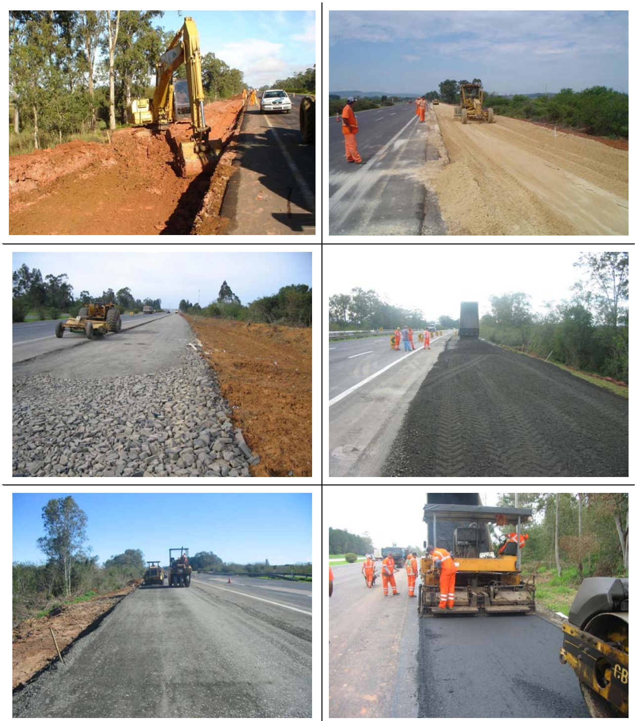
Figura 17: Fotos da execução da ampliação da rodovia BR-290/RS.
