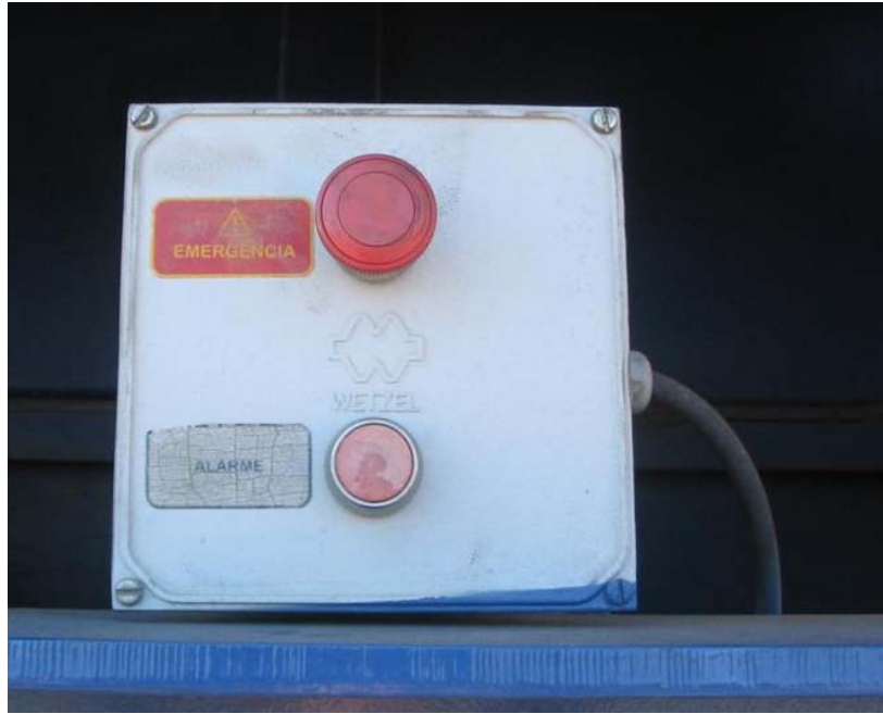
Figura 33: Detalhe do sistema de emergência do simulador de tráfego.
