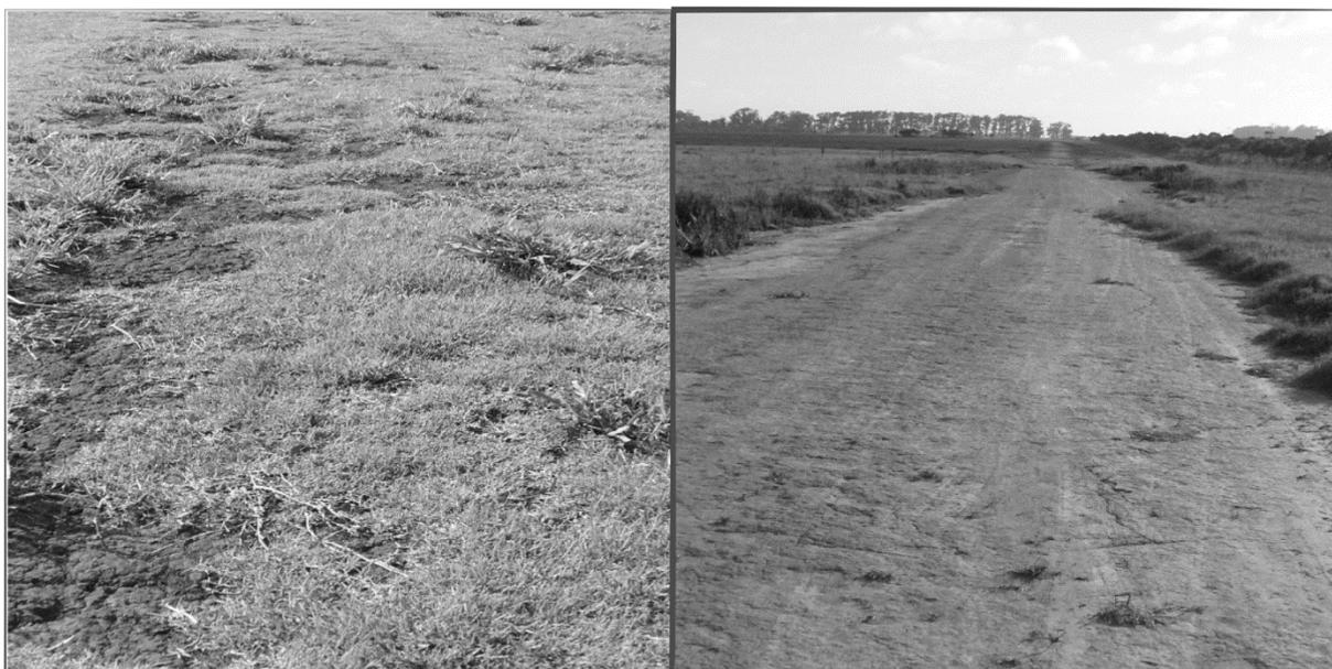
Figura 15 - Irregularidade de superfície das áreas de pouso.
