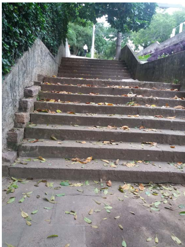
Figura 19 - Escadaria em uma calçada do bairro Rio Branco
