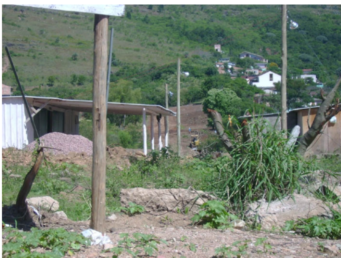
área já terraplanada (início da subida)
