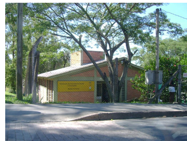
módulo nordeste da FASC (Fundação de Assistência Social e Cidadania)
