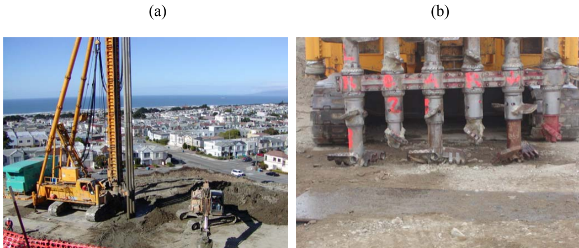
Figura 13 - (a) Mastro de CDSM no reservatório Sunset (Sunset North Basin Dam); (b) detalhe da ferramenta de mistura utilizada, que faz simultaneamente múltiplos furos.
