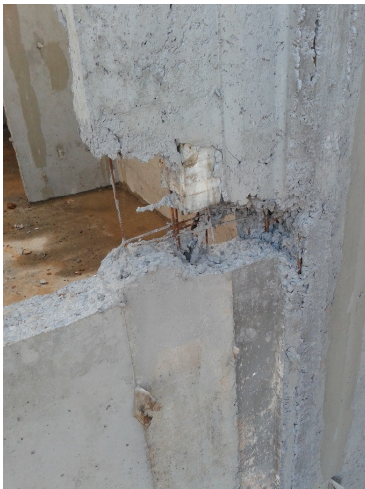
Figura 20 – Nichos de concretagem em volta de um dispositivo e próximo à janela
