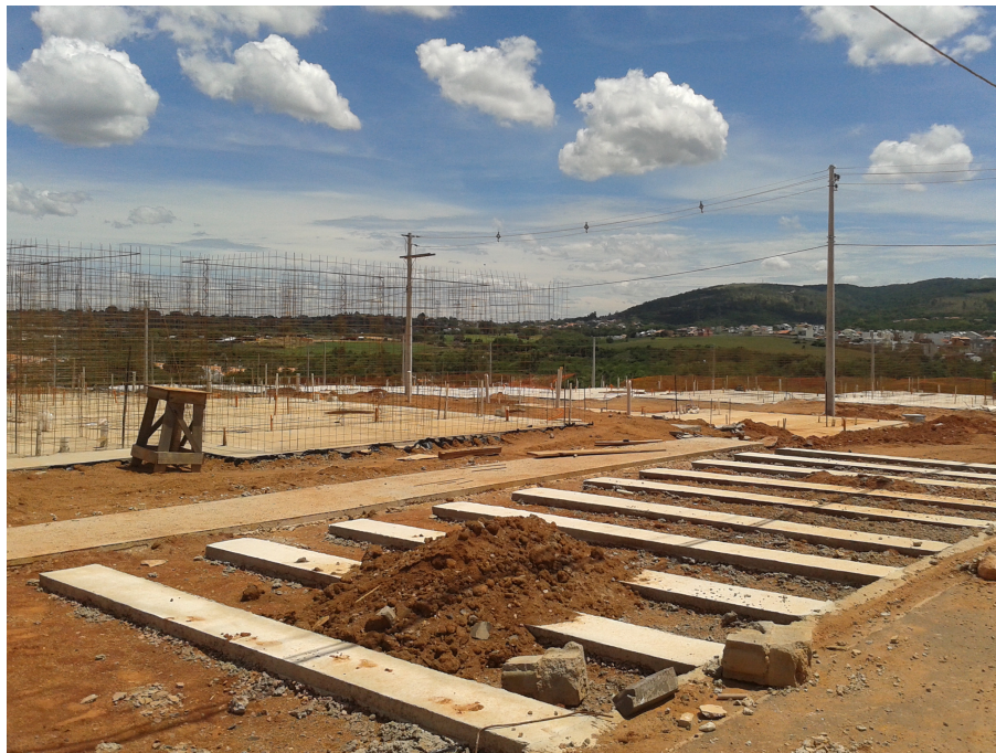
Figura 6 – Execução de radier e tubulações embutidas no mesmo
