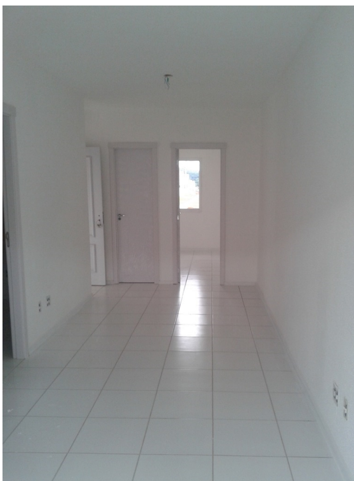
Figura 17 – Esquadrias, revestimentos cerâmicos e demais acabamentos executados
