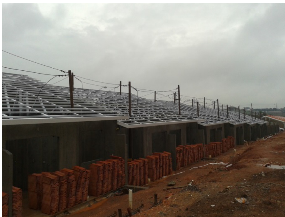
Figura 14 – Execução da estrutura da cobertura telhamento
