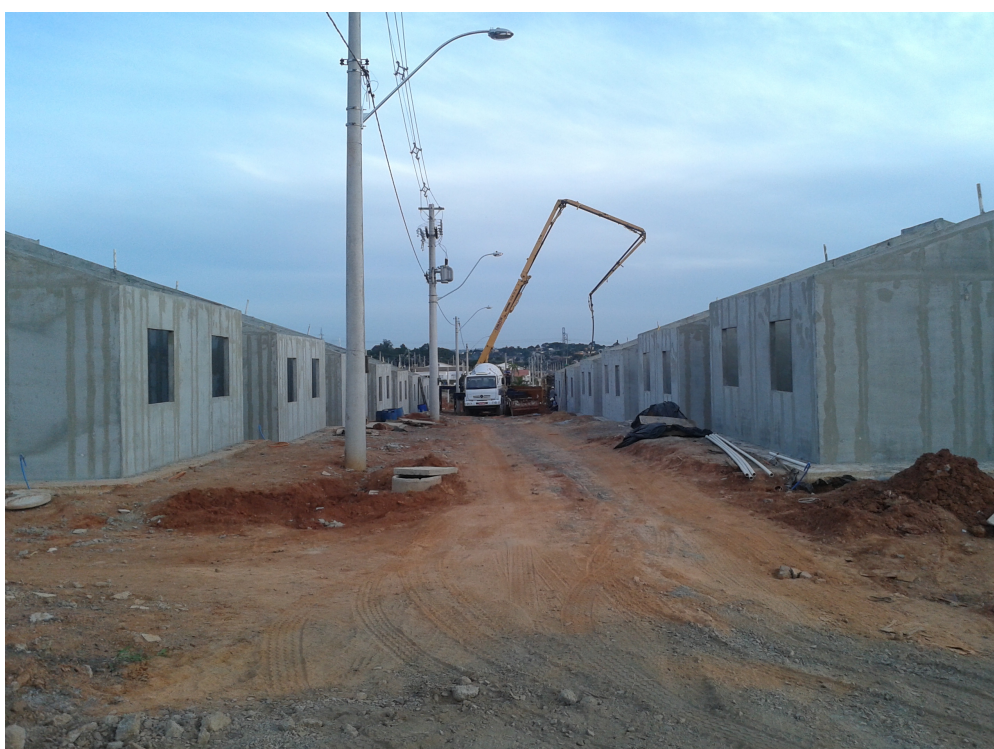
Figura 12 – Lançamento do concreto
