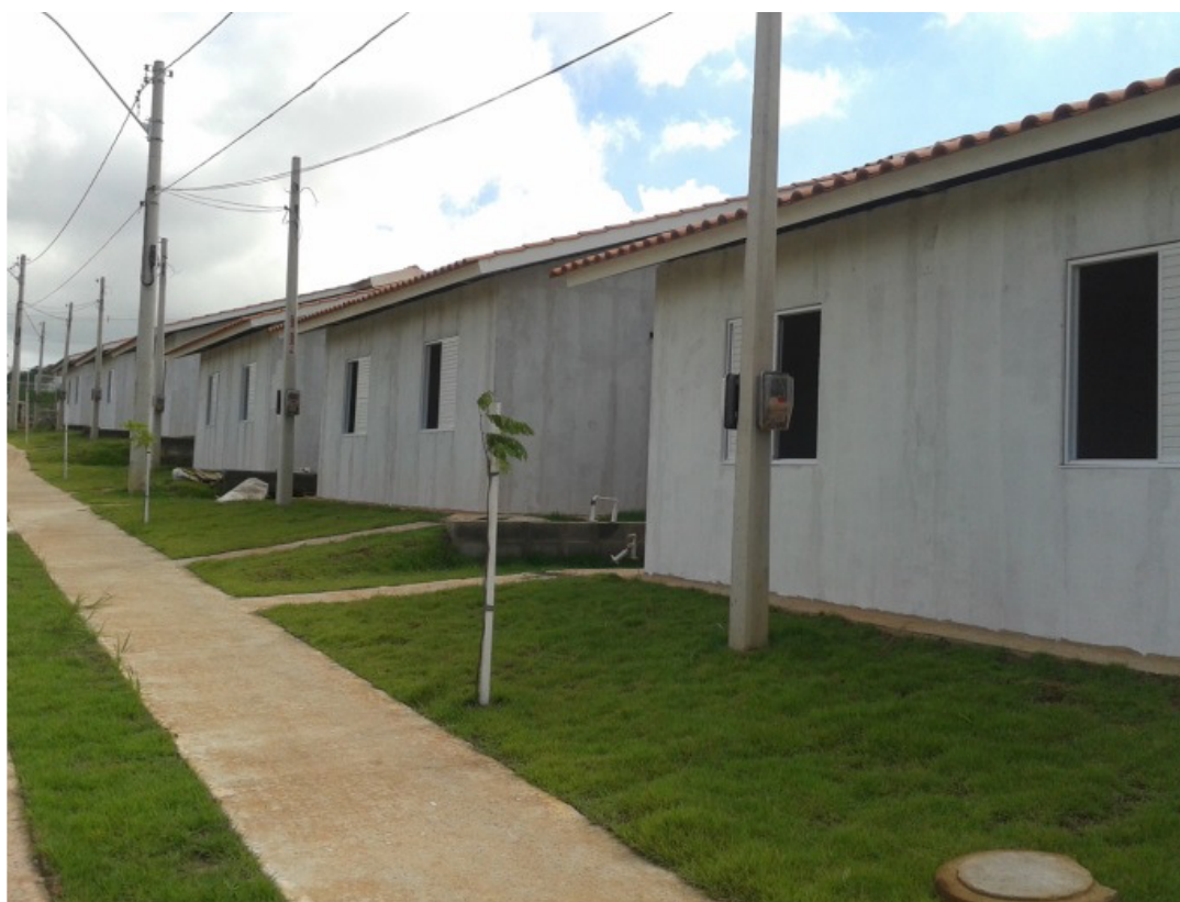
Figura 18 – Execução da aplicação de selante nas paredes externas
