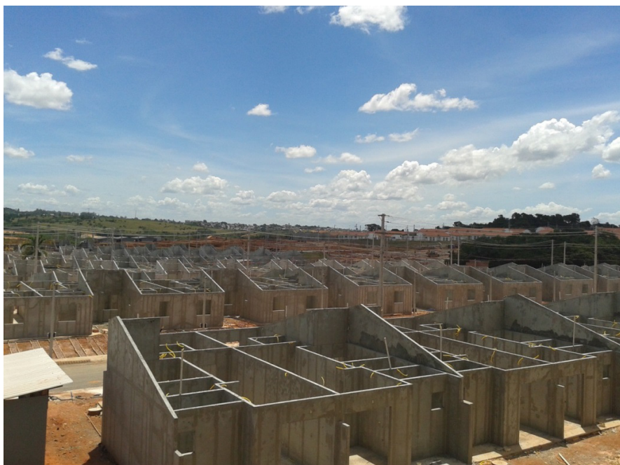
Figura 13 – Casas concretadas e desenformadas
