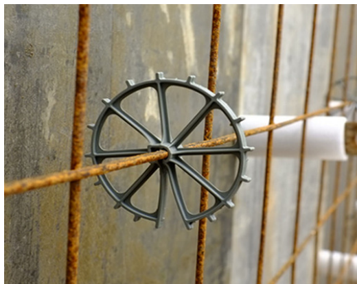
Figura 8 – Espaçadores fixados na armadura
