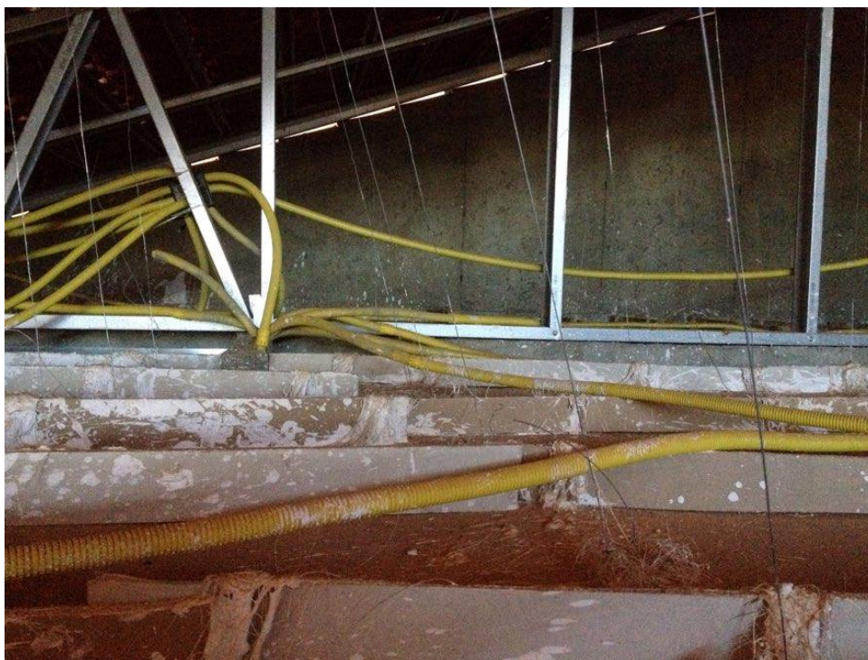
Figura 15 – Presilhas de fixação do forro de gesso acartonado
