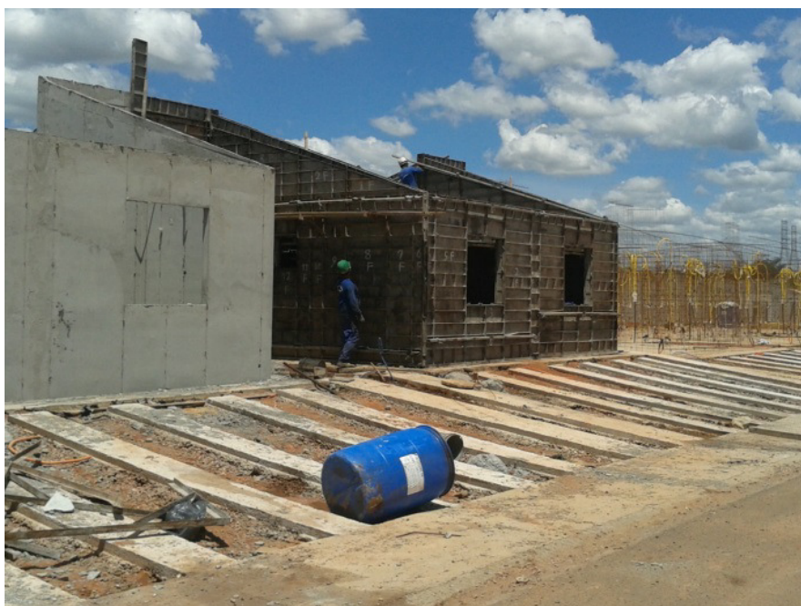
Figura 2 – Execução de paredes pelo método de paredes moldadas no local
