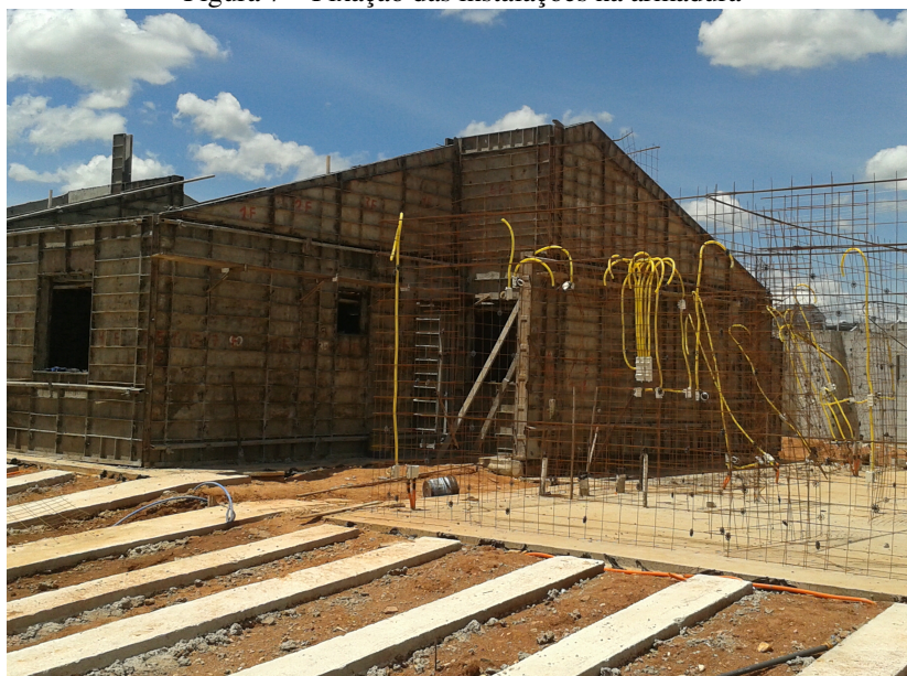
Figura 7 – Fixação das instalações na armadura
