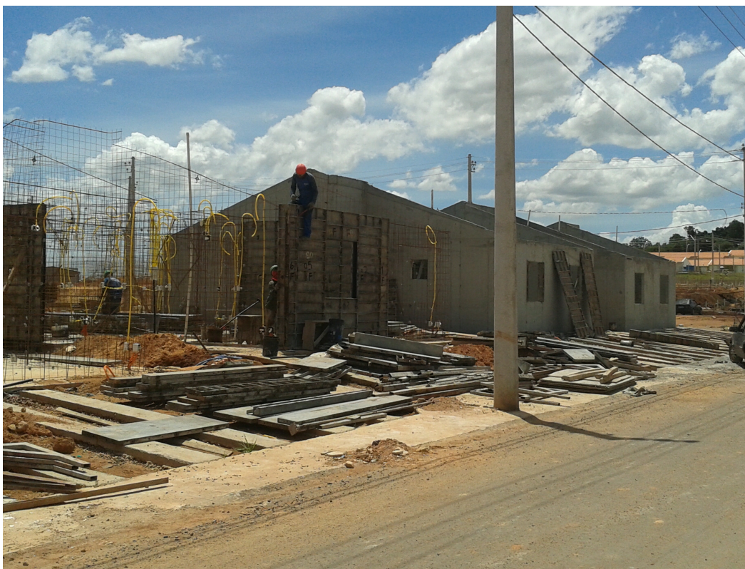
Figura 10 – Montagem das fôrmas metálicas
