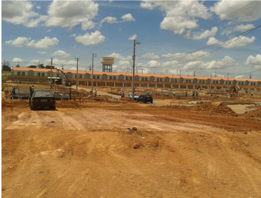
Figura 5 – Nivelamento do terreno para execução da fundação ( radier )
