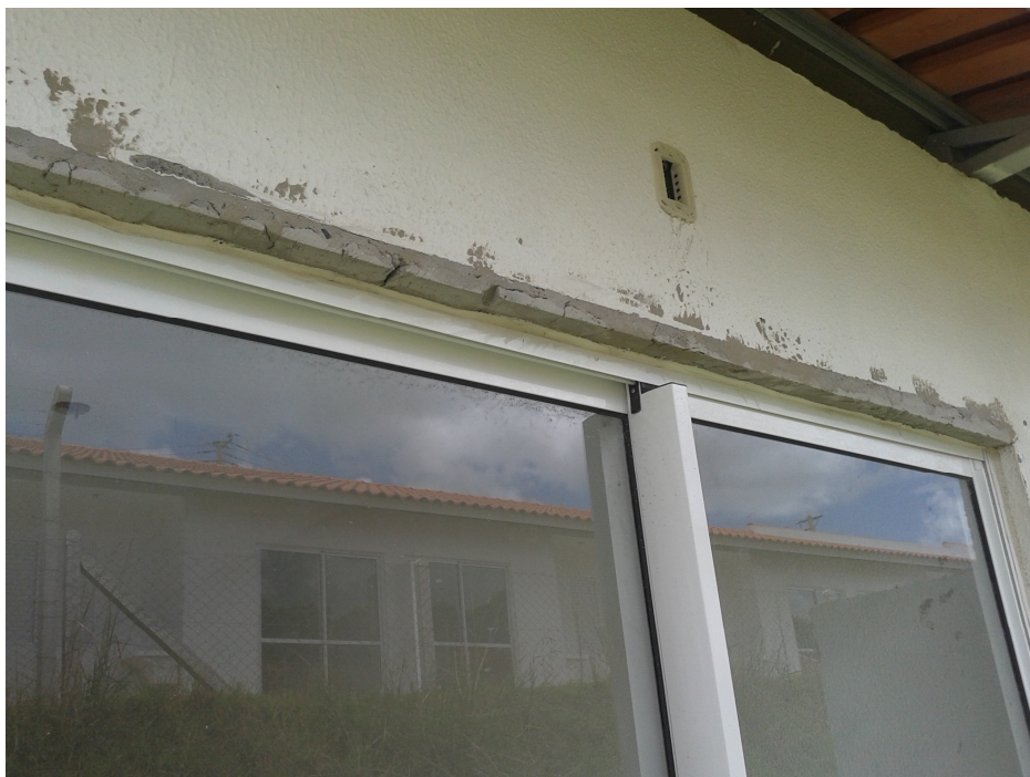
Figura 26 – Preenchimento do vão para o encaixe adequado da esquadria
