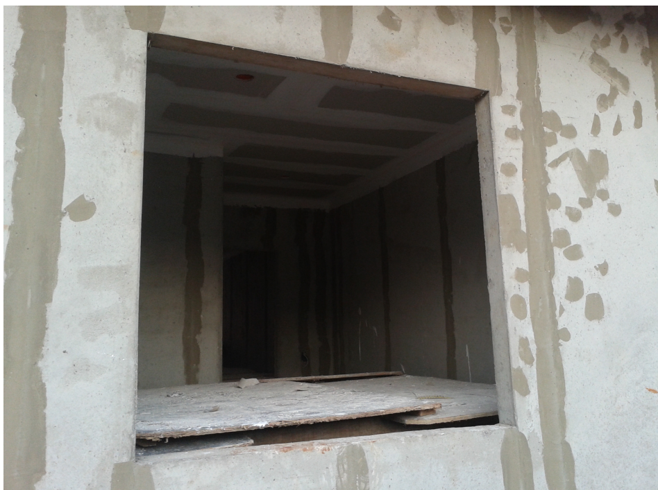
Figura 16 – Execução do forro de gesso acartonado
