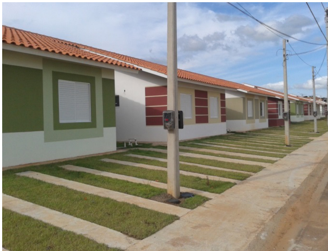
Figura 3 – Casas térreas construídas pelo método de paredes de concreto armado moldadas in loco
