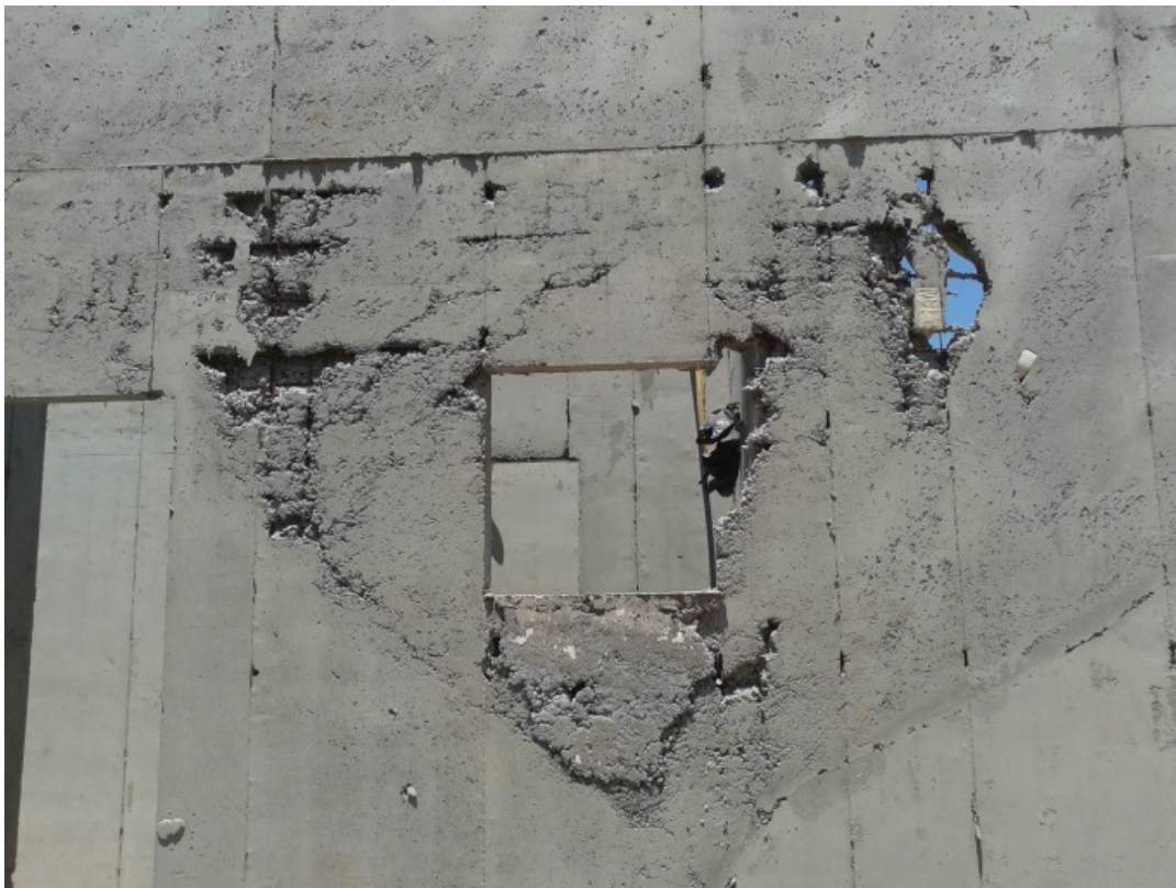
Figura 19 – Nichos de concretagem ao redor de uma janela
