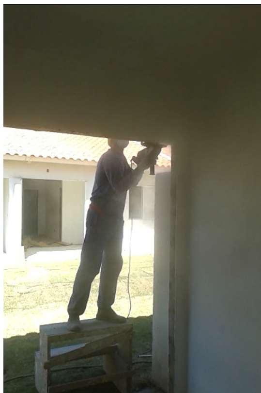
Figura 23 – Corte de vãos utilizando serra policorte
