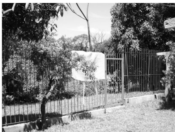
Figura 21: Gradil e portão de acesso aos fundos do lote.
