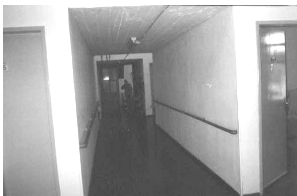
Figura 15: Corrimãos e piso antiderrapante no corredor de acesso aos dormitórios
