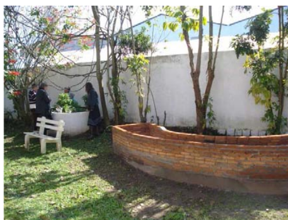
Figura 44: Canteiro elevado construído com sobras de tijolos.
