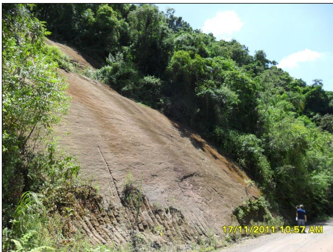
Figura 4 - Área de deslizamento em substrato rochoso, divisa dos municípios de Igrejinha e Três Coroas - RS.
