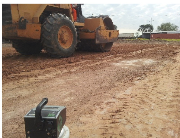
Figura 3.13 Compactação para avaliação da energia fornecida pelo compactador
