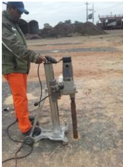
Figura 3.23 Equipamento equipamento perfuratriz rotativo com motor elétrico
