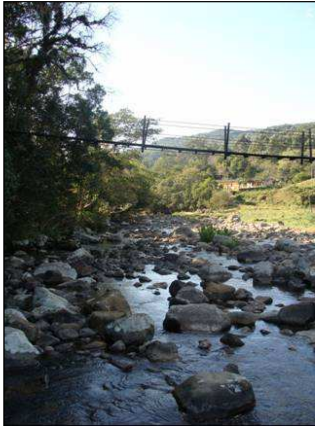
Figura 58 – Ponte pênsil sobre rio do Terra na comunidade de Mães de Morro azul. Três Cachoeiras. Foto Rosvita Schütz.
