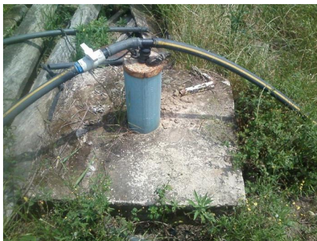
Figura 2: Poço artesiano não jorrante de uma das famílias da localidade do Quatepe, Quaraí/RS
