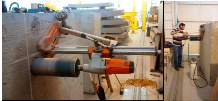
Figura 7. Etapas de avanço das perfurações
