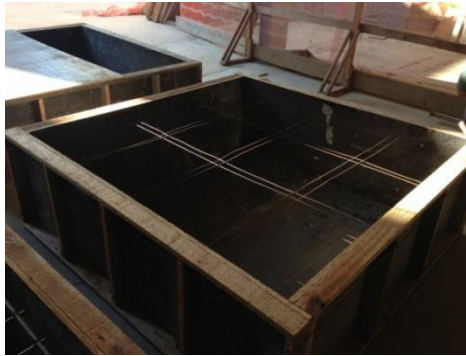
Figura 1. Fôrmas para concretagem das paredes.
