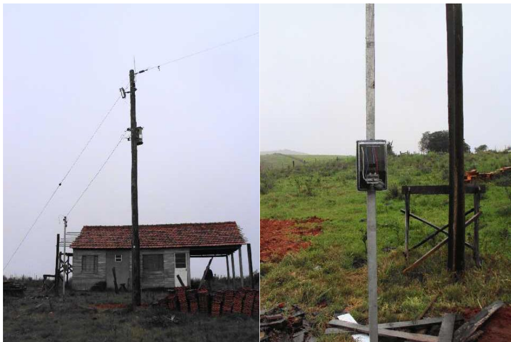
Figura 3: Residência do Sr. Paulo e poste padrão de energia no local
