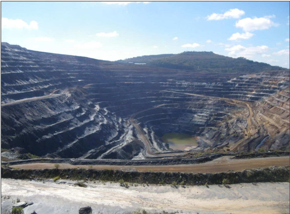
Figura 9. Foto da mina de Conceição apresentando as bancadas geradas pelo método de lavra em cava
